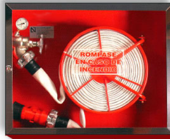
Figura 3.2.13.6.2 – Boca de Incendio Equipada (BIE).
