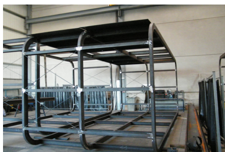
30 Imagen de la estructura del módulo de vestuarios, realizada por Prometal en 2011
