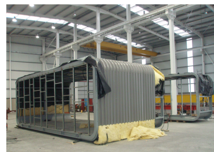
26 Imagen del modelo A en construcción en el taller, realizada por Prometal en 2011
