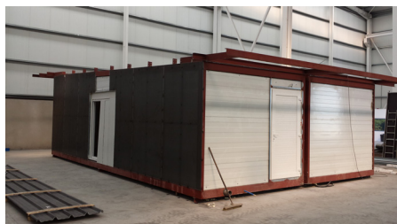
49 Imagen del modelo C en construcción en el taller, realizada por Prometal en 2012
