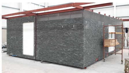
48 Imagen del modelo C en construcción en el taller, realizada por Prometal en 2012
