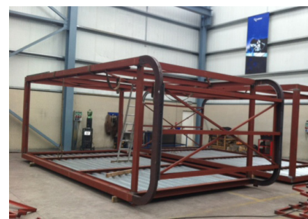
44 Imagen de la estructura del modelo B, realizada por Prometal en 2012
