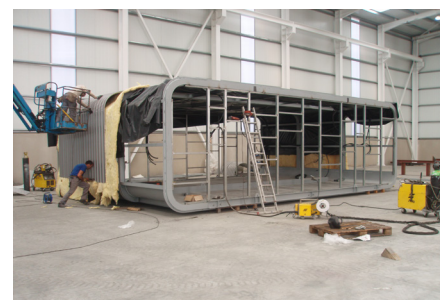
25 Imagen del modelo A en construcción en el taller, realizada por Prometal en 2011
