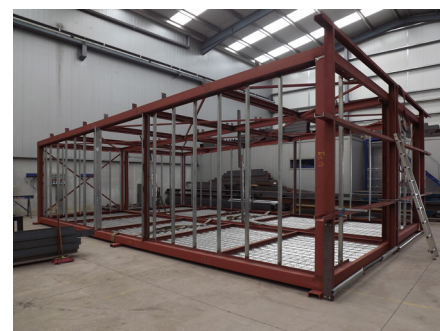
58 Imagen de la estructura del modelo C en construcción en el taller, realizada por Pro-metal en 2012
