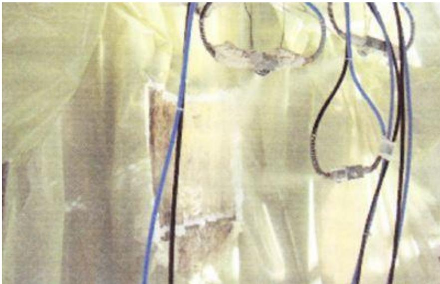
Fig.73.- Limpieza de fachada mediante agua atomizada por difusores.
