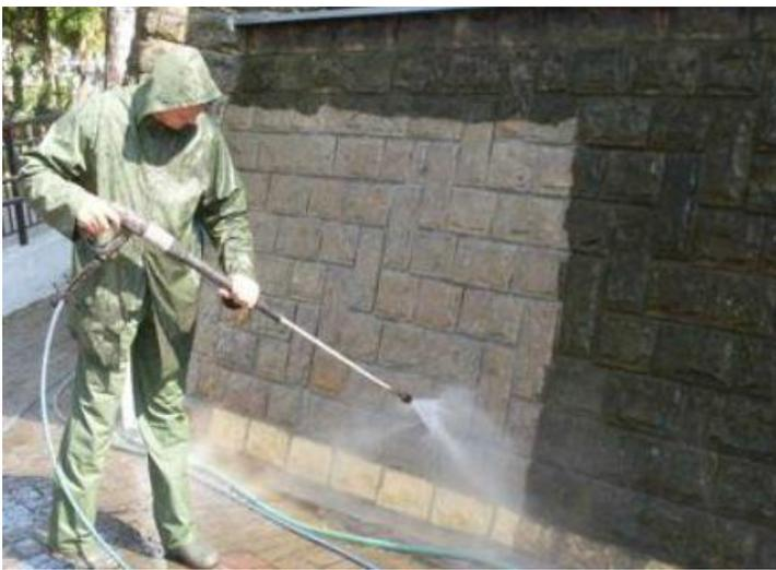
Fig.71.- Limpieza de fachada de edificio sin valor monumental o artístico mediante chorro de agua a presión.
