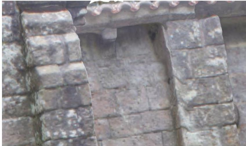
Fig.10. – A la izquierda contrafuerte gótico, a la derecha contrafuerte románico.
