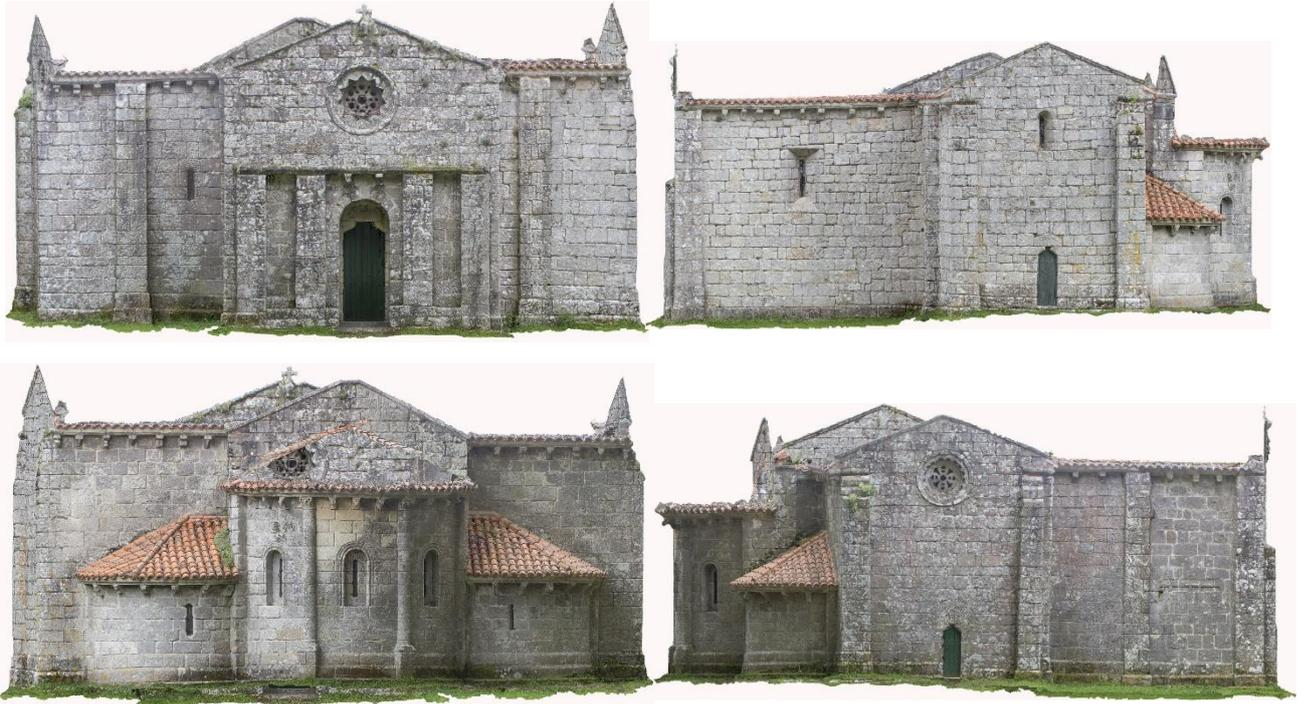
Fig. 32, 33, 34 y 35. – Vistas ortográficas de las cuatro fachadas de San Miguel de Bremao. De izquierda a derecha y de arriba abajo: fachada oeste, fachada sur, fachada este, fachada norte. Imágenes 32, 33, 34 y 35 propias, extraídas del modelo 3D.
