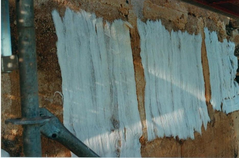
Fig.72.- Aplicación de apósitos con agua desionizada en una fachada de piedra
