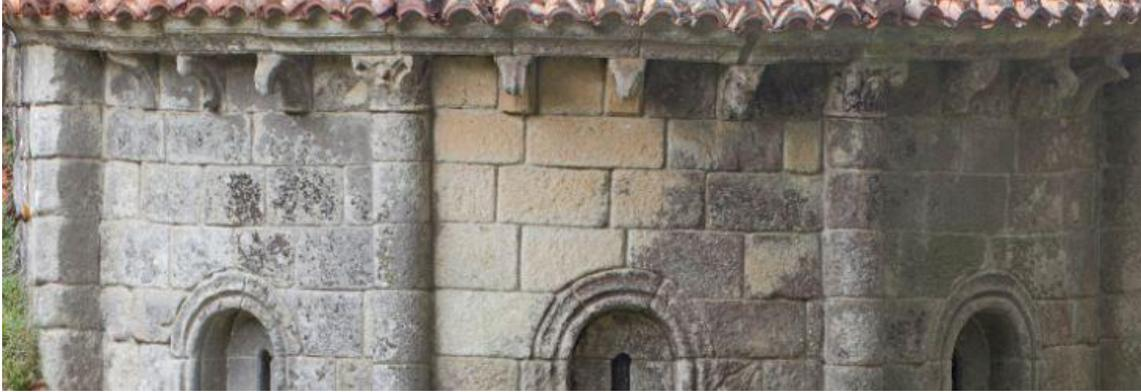
Fig.11. – Parte superior del ábside central en el que se aprecia la disposición de los canecillos en cada vano.
