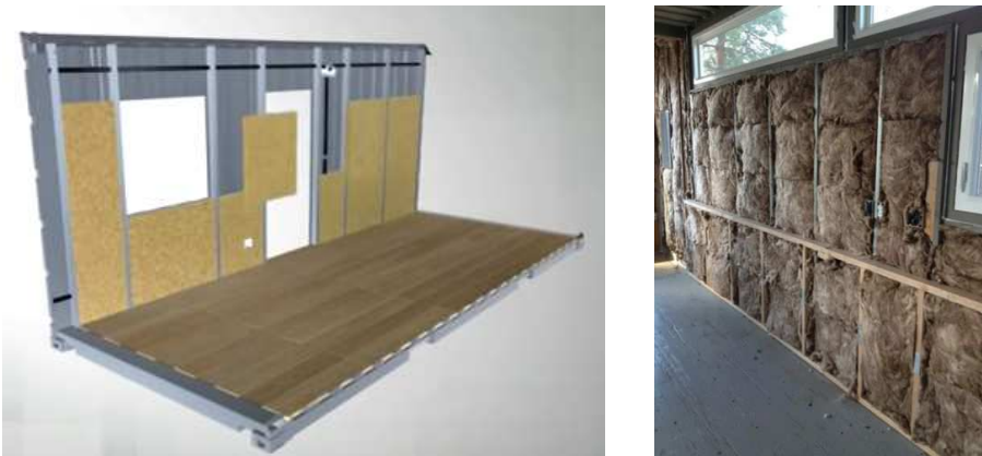
Colocación del aislamiento. Fuente: Contenhouse
