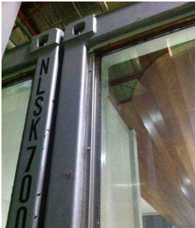
Unión containers. Fuente: blog construcción, Enrique Alario
