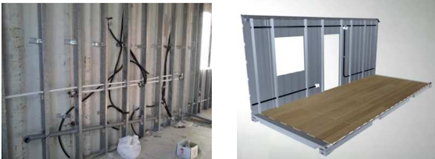
Colocación de las canalizaciones. Fuente: Contenhouse
