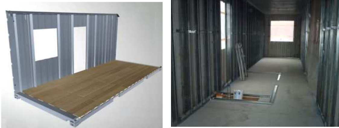
Colocación de la perfilería. Fuente: Contenhouse
