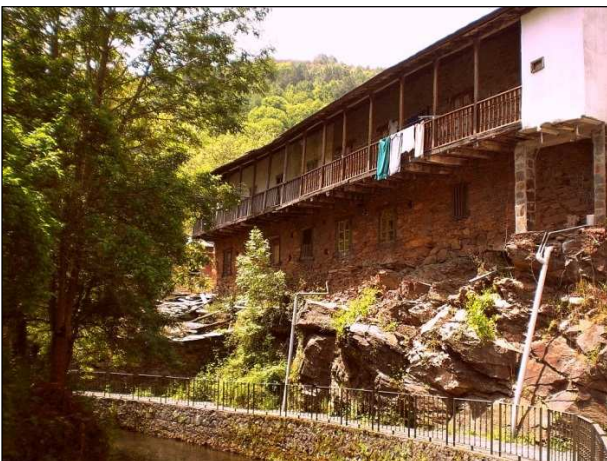
Arquitectura típica de las aldeas del Caurel
