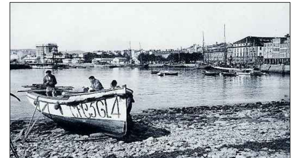
img22_Vista del Cantón Grande y Av. de la Marina desde la Dársena.
