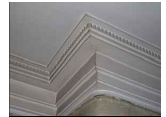
img49_Viga P4 grietas
