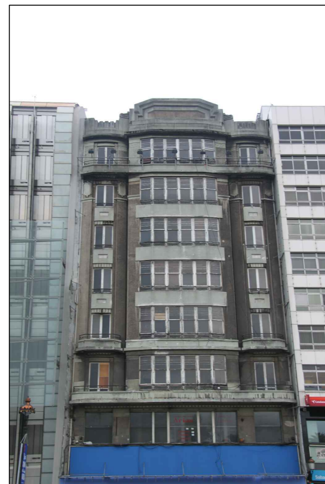
img35_Estado actual fachada principal [ref.13]
