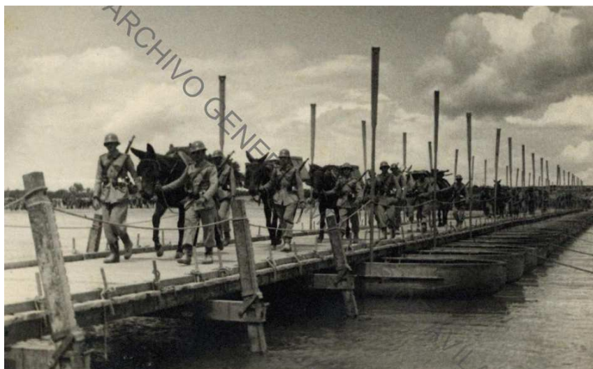
Unidad de pontoneros marchando sobre un puente de barcas construido sobre el río Ebro 132 .
