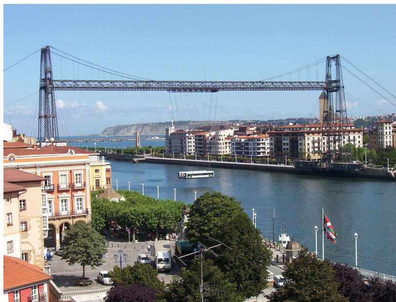
Imagen actual del puente de Portugalete.
