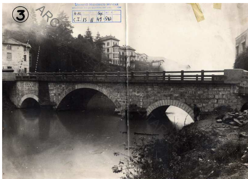
Vista del puente de la Conchita tras su reparación.
