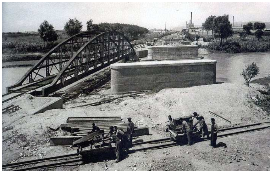
Puente de Tres Puntas dispuesto en paralelo al puente sobre el río Llobregat.
