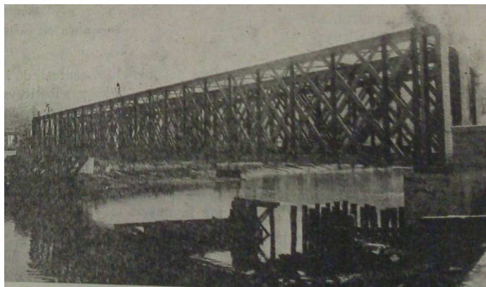
Puente sobre el Cadagua tras su reconstrucción definitiva 253 .
