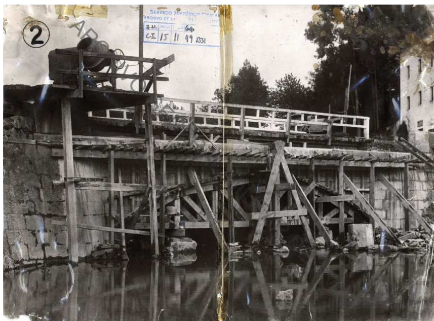
Reconstrucción de puente (sin identificar). La parte superior del puente provisional está formado por vigas de hierro y tablero de madera tendido por encima de la rasante 195 .
