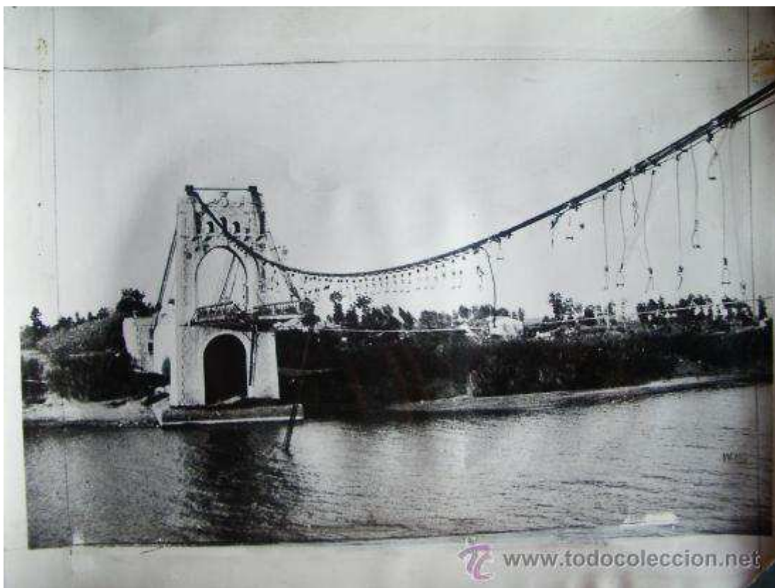
Puente de Amposta tras su destrucción. Se aprecian los montantes rotos y el cable de suspensión totalmente destrozado.
