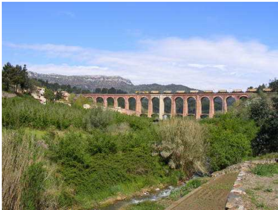
Imagen actual del viaducto de los Massos en la que aún se aprecia la diferencia de los arcos centrales ejecutados con hormigón.
