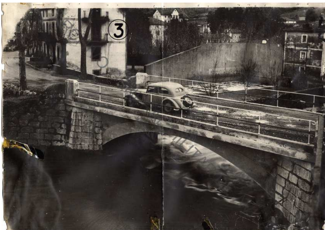
Imagen de puente parabólico reconstruido. Se aprecian las dimensiones de los espesores en clave y arranques 208 .
