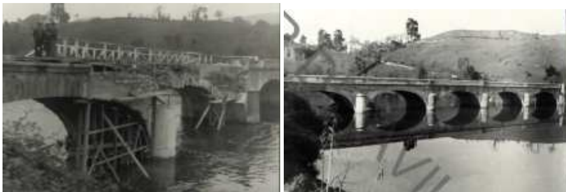
Puente de Pasues de directriz parabólica reparado durante la guerra civil española 207 .
