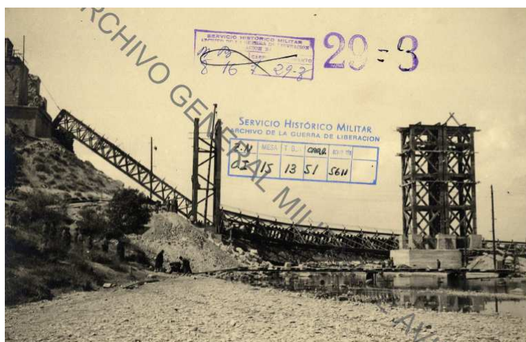
Imagen de los castilletes construidos para el puente sobre el río Alcanadre 239 .
