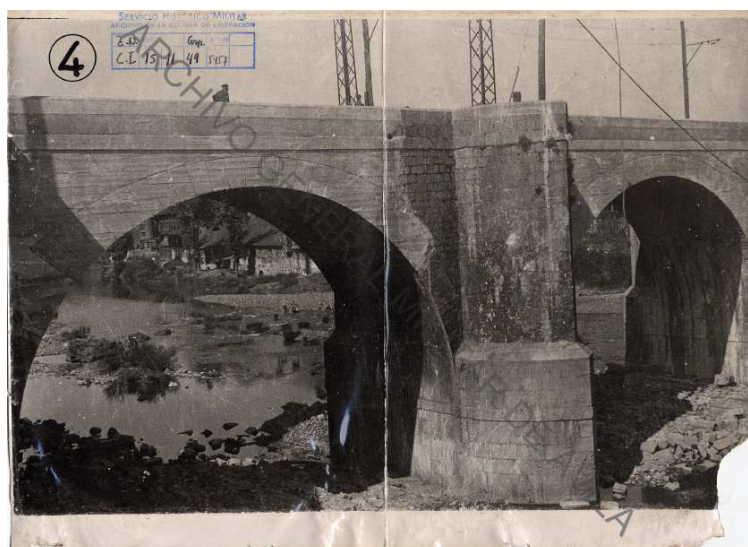
Puente de Bolueta tras su reconstrucción.
