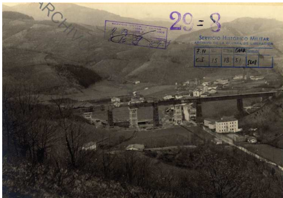
Imagen del viaducto de Ormaiztegui tras su reconstrucción 333 .
