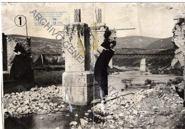
Puente de Bolueta tras su destrucción.
