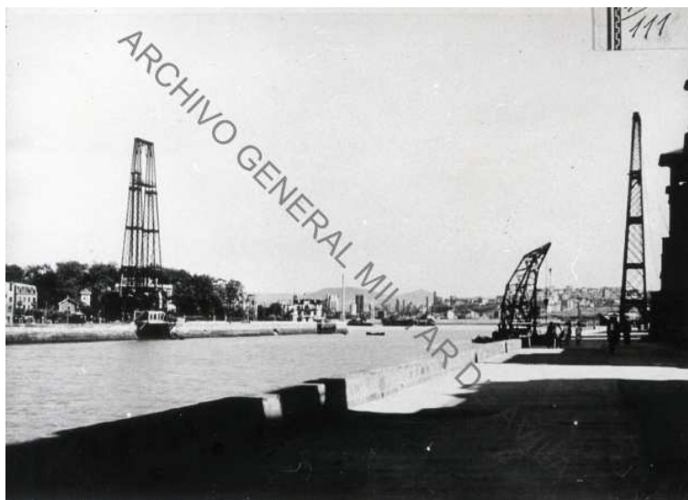
Puente de Portugalete tras su destrucción y tras la retirada del cauce del tramo caído. Sólo quedan en pie las torres de sustentación 355 .
