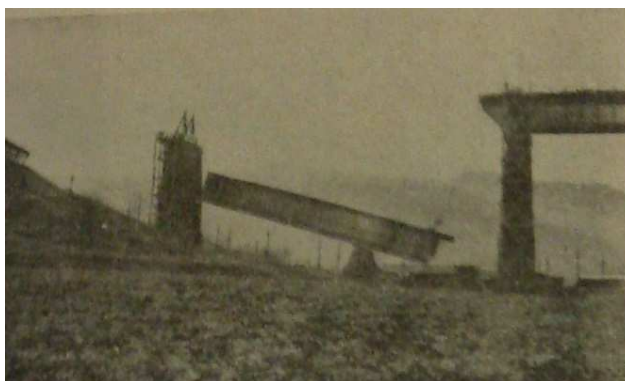
Imagen de los trabajos de reconstrucción del Viaducto de Ormaiztegui durante el descenso del
