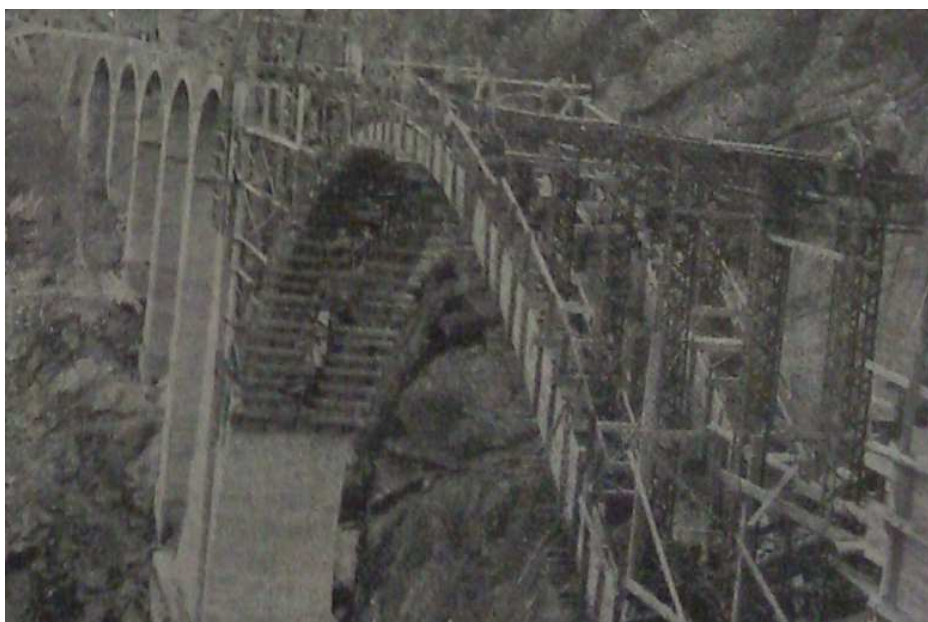
Disposición de la cimbra para el hormigonado del puente sobre el Jerte 127 .
