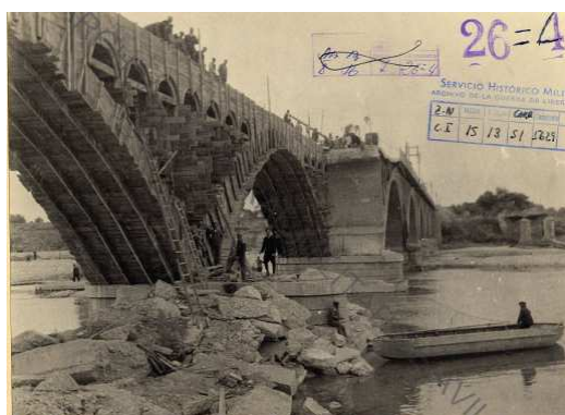
Encofrados dispuestos para el puente de ferrocarril sobre el río Cinca en Monzón.
