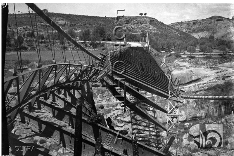
El puente de Lascellas tras su destrucción 342 .
