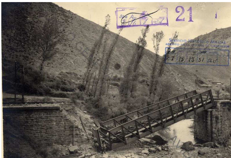
Estribo dañado que provocó la caída del tramo metálico del puente de ferrocarril sobre el Bernesga 218 .
