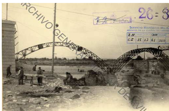
Cimbras rígidas para la reconstrucción del puente de ferrocarril sobre el río Cinca en Monzón.
