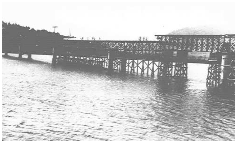
Imagen de puente sobre caballetes 134
