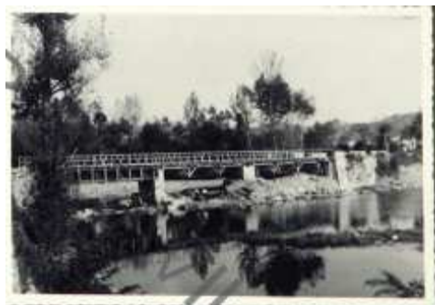
Pasarela tendida sobre puente de piedra destruido, con apoyos intermedios de madera 191 .
