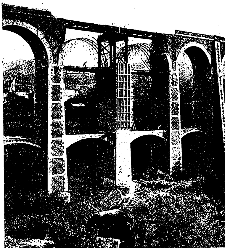
Viaducto de los Massos durante su reconstrucción 305 .
