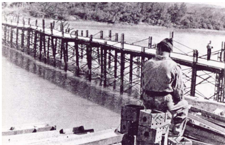
Puente de tipo pontezuelo tendido en Mora de Ebro 137 .
