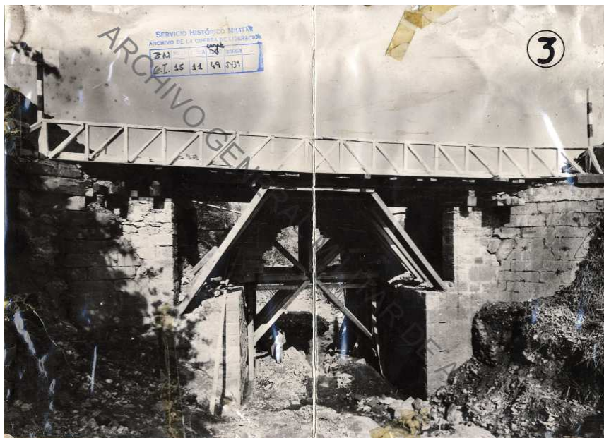
Imagen de la palizada de madera construida para mantener el paso en el puente de San Antón.
