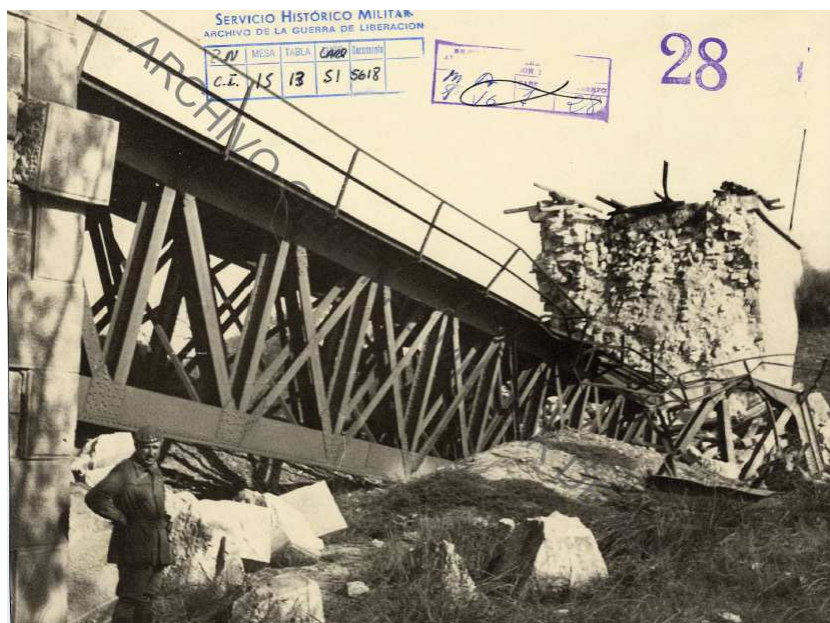
Imagen de los daños sufridos en la pila del 5º paso del Matarraña, que produjo la caída del tramo metálico 221 .
