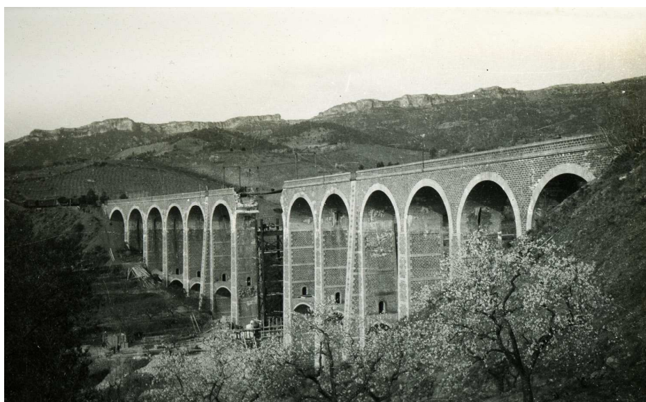
Imagen del puente de los Massos. Se aprecia la destrucción de los arcos centrales. La reconstrucción ya se había iniciado en esta instantánea.
