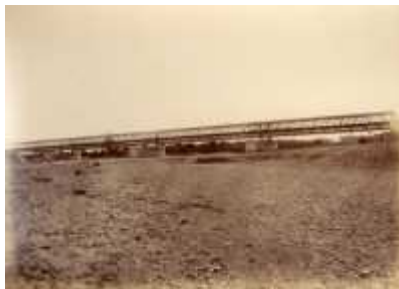
Imagen del puente sobre el río Manol, metálico de cuatro tramos, antes de entrar en Figueras. 1879_FA/0025-021
