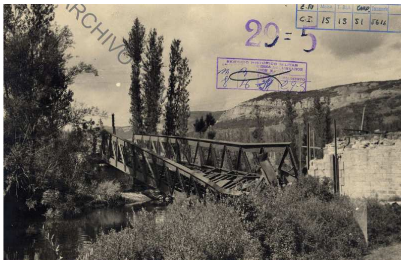
Viga dañada por el giro del tramo metálico 247 .
