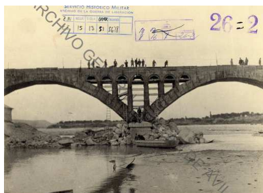
Vista frontal de la reconstrucción del puente sobre el río Cinca en Monzón.
