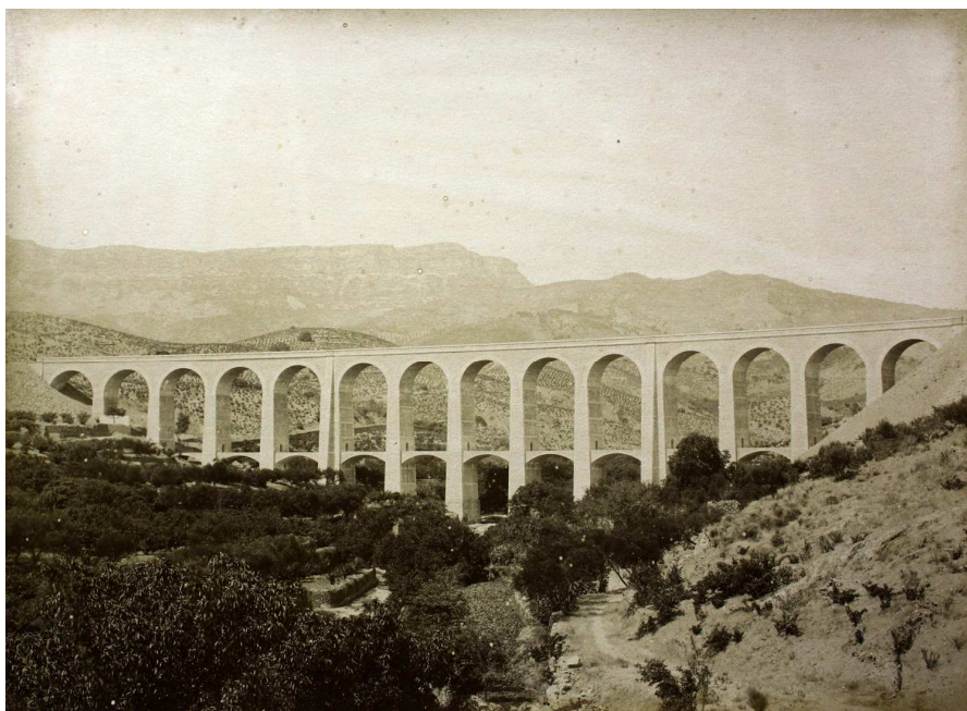
Viaducto de los Massos tras su construcción.
