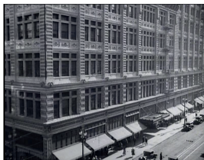
Fig. 06 - Grandes almacenes , exterior
