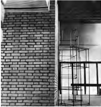
Fig. 1. Exposición de las Telecomunicaciones en el Palacio de Exposiciones del Retiro, Madrid (1955). Detalle de la instalación.
