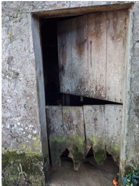
16. Puerta principal de acceso a vivienda desde el exterior de la finca. (Fuente: Propia)
