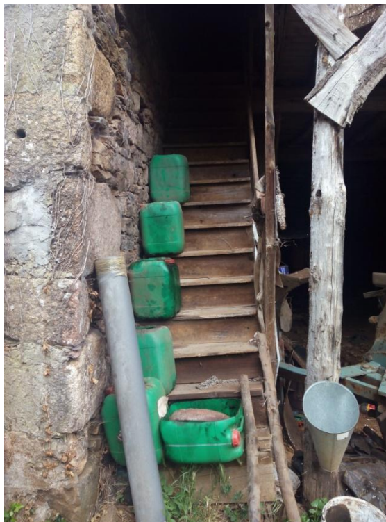
27. Escalera de acceso al bajocubierta del ala SurOeste. (Fuente: Propia)
