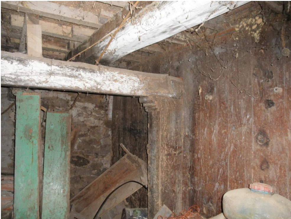
20. Vigas la antigua cocina. (Fuente: Propia)
