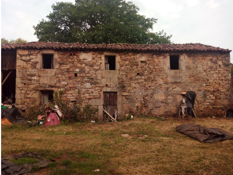
8. Fachada SurEste desde el interior de la parcela. (Fuente: Propia)
