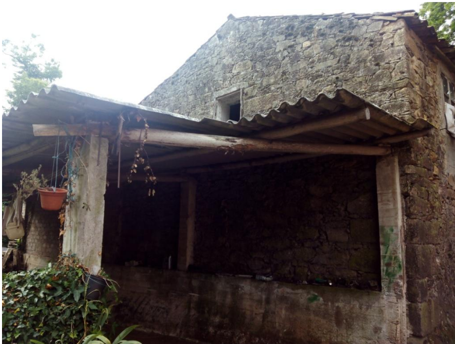
11. Fachada NorEste desde exterior de la parcela. (Fuente: Propia)
