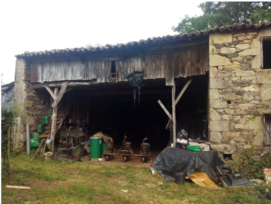
9. Fachada SurEste desde el interior de la parcela. (Fuente: Propia)
