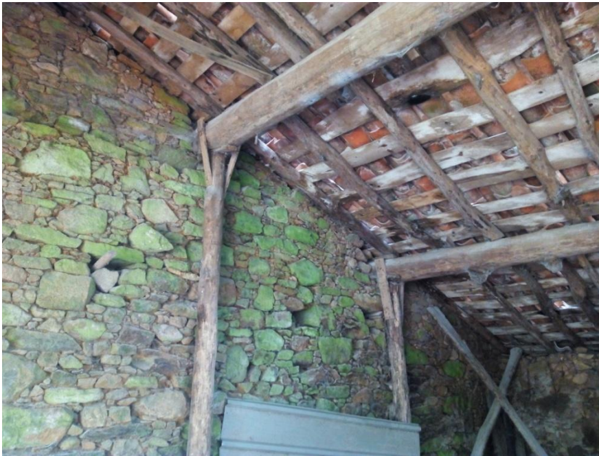
26. Cubierta del ala SurOeste. (Fuente: Propia)
