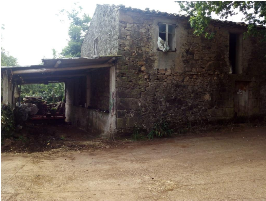
12. Esquina entre fachadas NorEste y NorOeste desde el exterior de la parcela. (Fuente: Propia)
