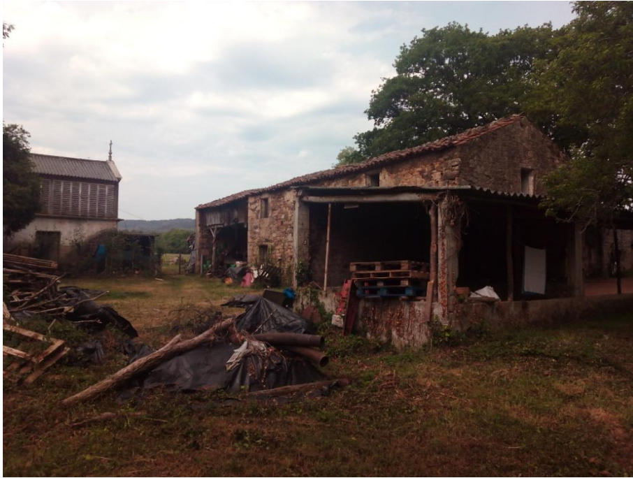
10. Esquina entre fachadas SurEste y NorEste desde el interior de la parcela. (Fuente: Propia)
