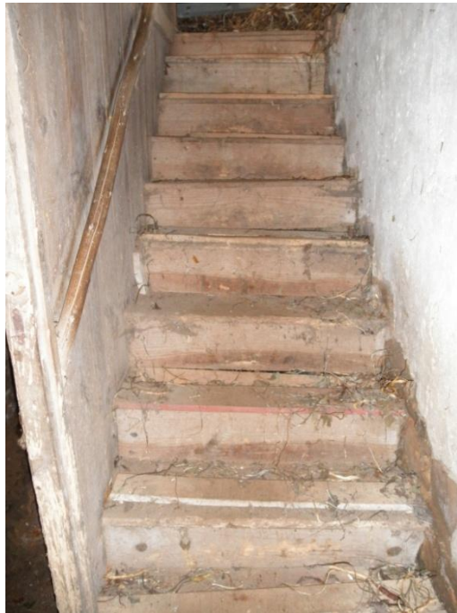
28. Escalera de acceso a la planta primera vista desde panta baja. (Fuente: Propia)
