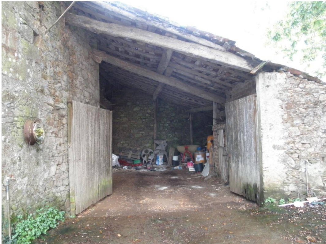
23. Puerta de acceso al ala SurOeste de la vivienda desde el exterior de la finca. (Fuente: Propia)
