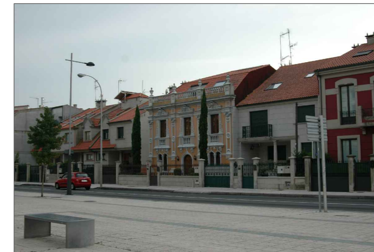
Edificaciones situadas en la Avda. Rosalía de Castro, en frente a la parcela en la que se ubica la Villa Güimil.
