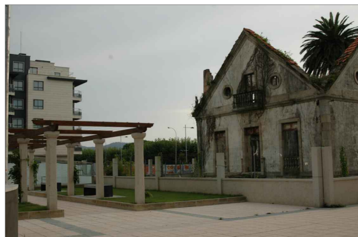
Vista fachada posterior de la edificación.
