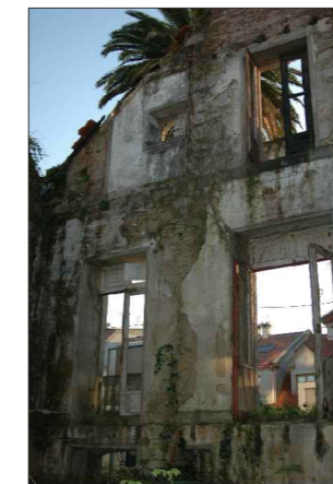
Fachada interior oeste.
