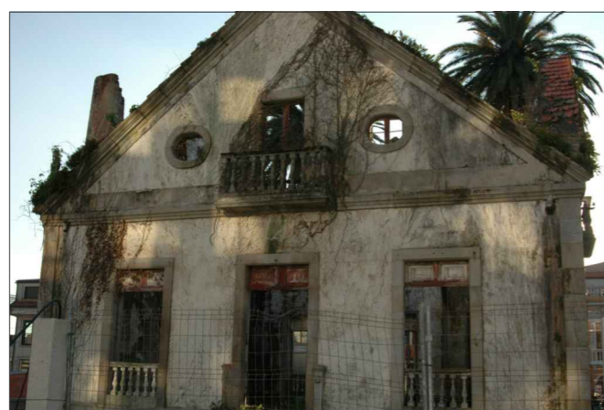
Fachada exterior este.
