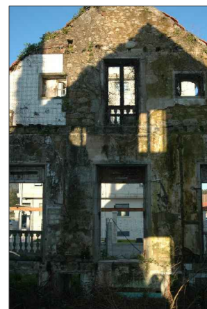
Fachada interior este.
