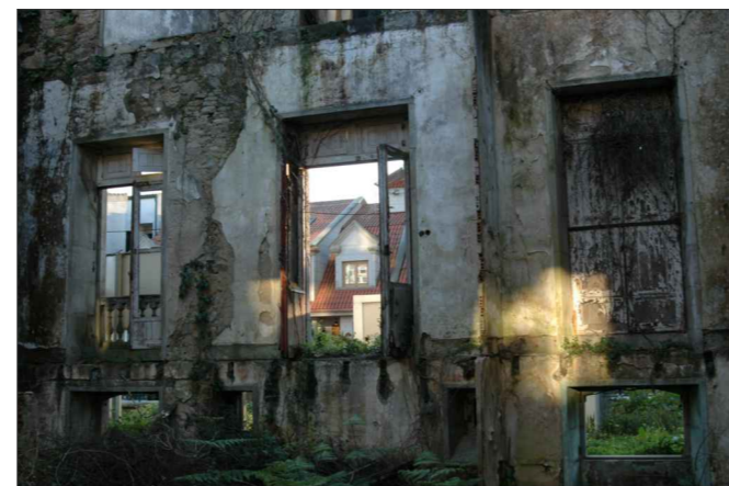
Fachada interior oeste.
