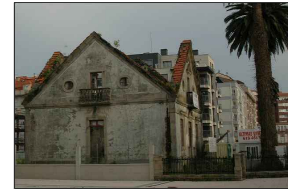
Fachada norte. Fachada lateral derecha
