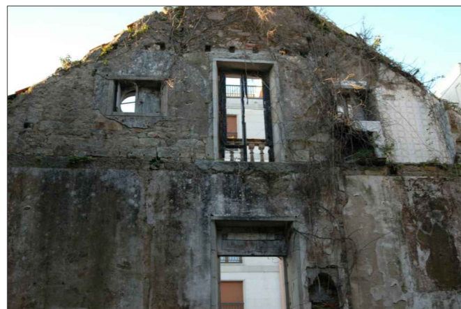
Fachada interior norte.
