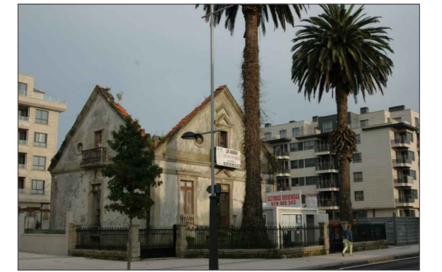
Encuentro fachada norte con fachada oeste
