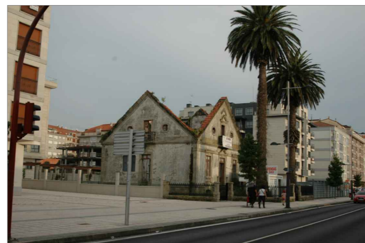
Vista lateral izquierdo de la edificación.
