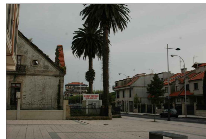
Vista fachada principal (oeste) con acceso por la Avda. Rosalía de Castro.
