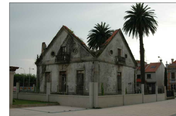
Encuentro fachada este con fachada norte
