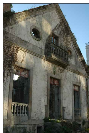
Fachada exterior este.
