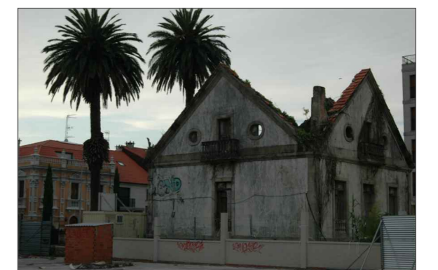
Encuentro fachada sur con fachada este
