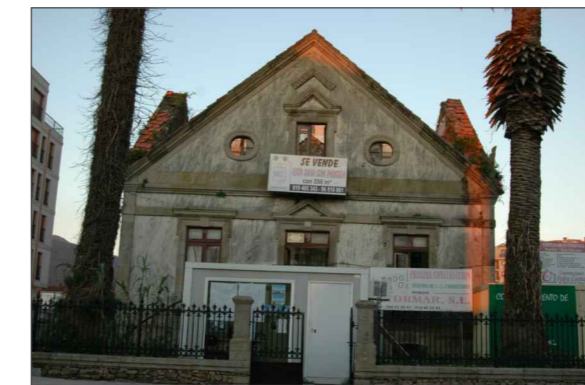
Fachada oeste. Fachada principal
