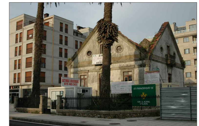
Vista fachada principal (oeste) con acceso desde la Avda. Rosalía de Castro.
