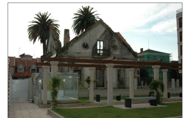
Fachada este. Fachada posterior
