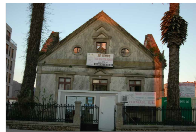
Fachada exterior oeste.
