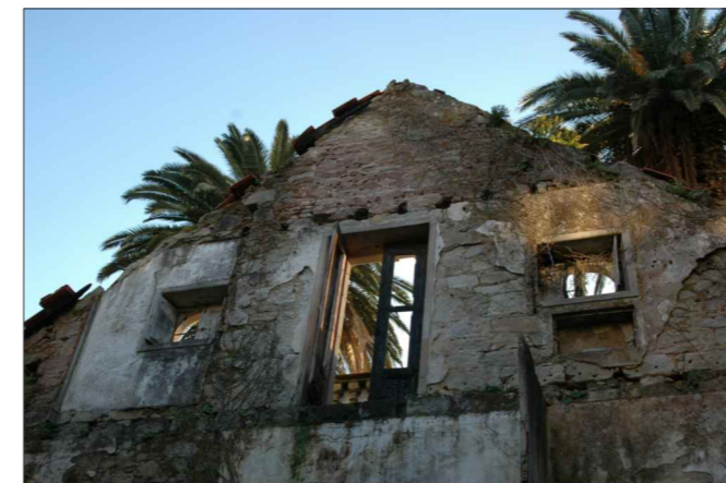
Fachada interior oeste.
