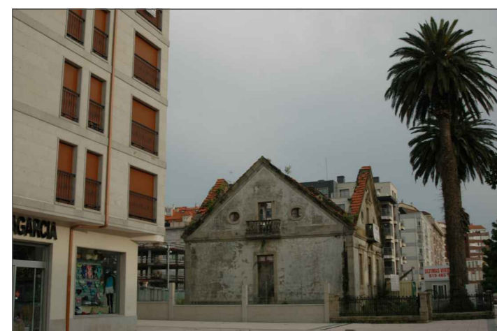
Encuentro fachada norte con oeste (principal). Se conserva parte del cierre original de la finca.
