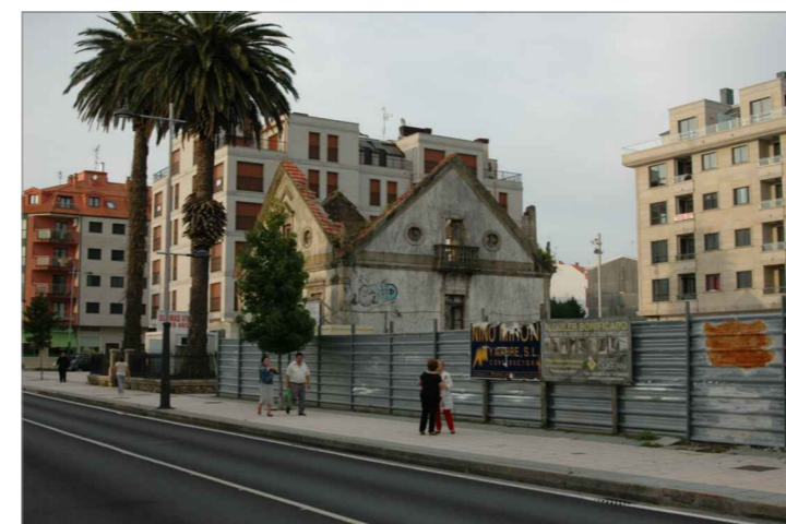
Vista lateral derecho de la edificación.
