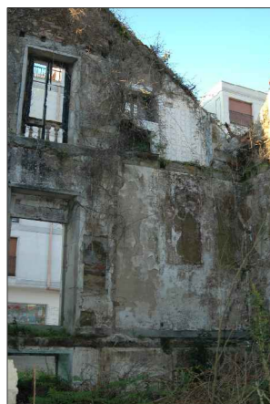
Fachada interior norte.
