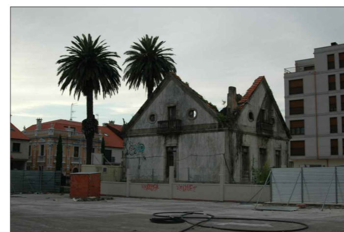
Encuentro fachada sur con este. Solar destinado a la construcción de otro edificio residencial.
