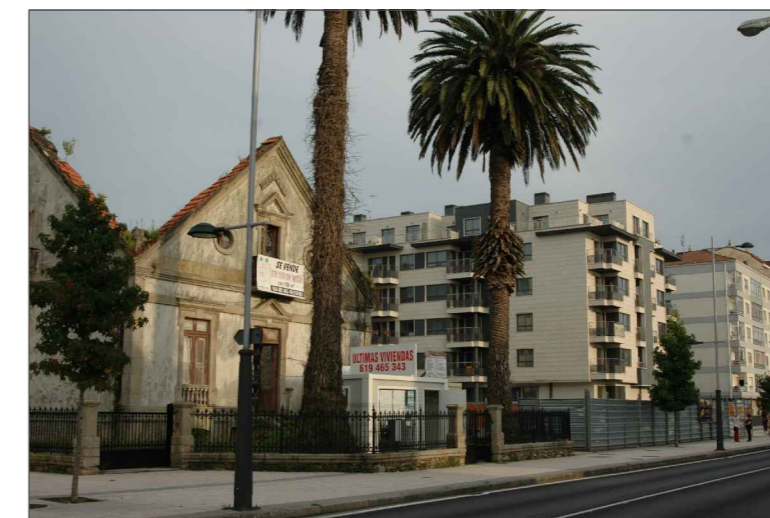
Vista fachada principal (oeste) y edificaciones situadas frente a la fachada sur.
