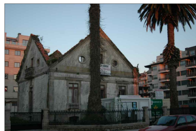
Fachada exterior oeste.
