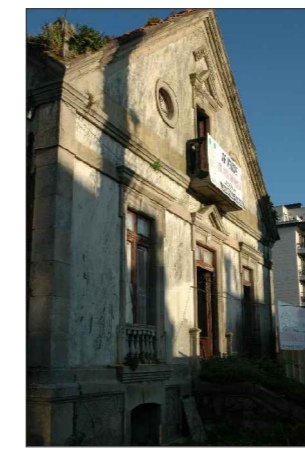
Fachada exterior oeste.
