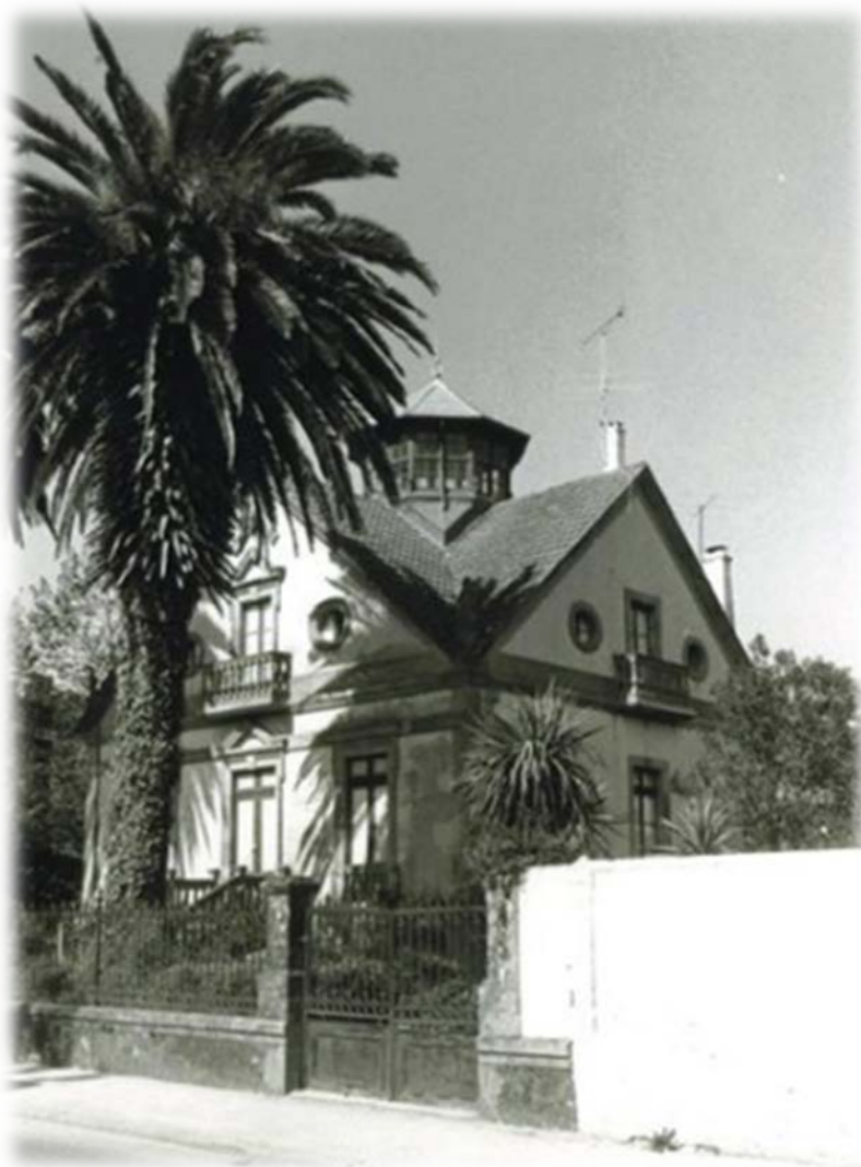
Imagen 26, tomada de la página web www.blogoteca.com/ofaiadodamemoria/index.php ; .la imagen está tomada desde la carretera Chapa Carril, perteneciente a la Avenida Rosalía de Castro.
