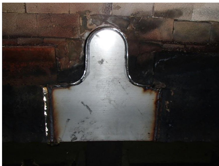
Figura 5. 4: Instalación de la tapa del dilatador
