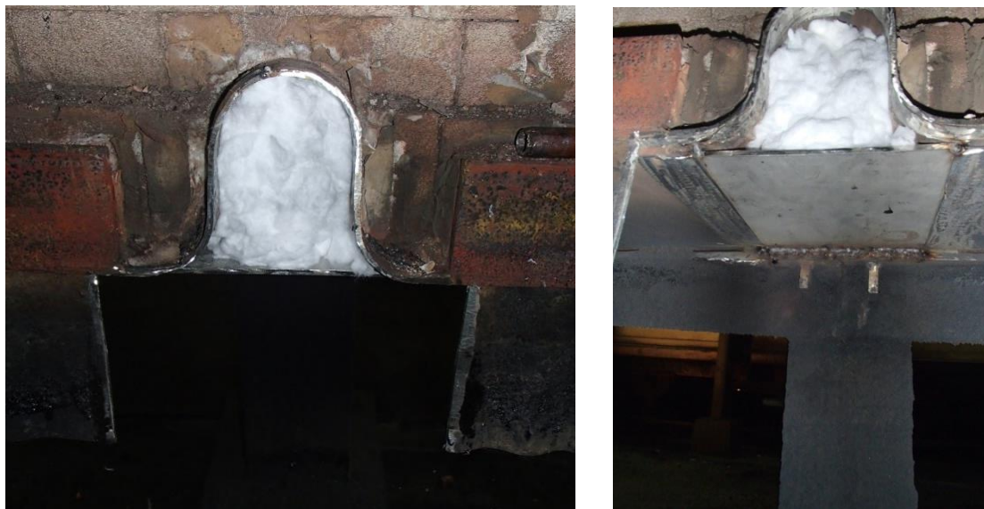
Figura 5. 3: Colocación de lana de roca en el interior del dilatador
