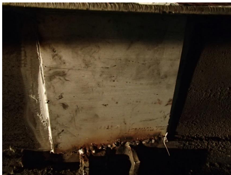
Figura 5. 2: Pletina soldada a la chapa del horno
