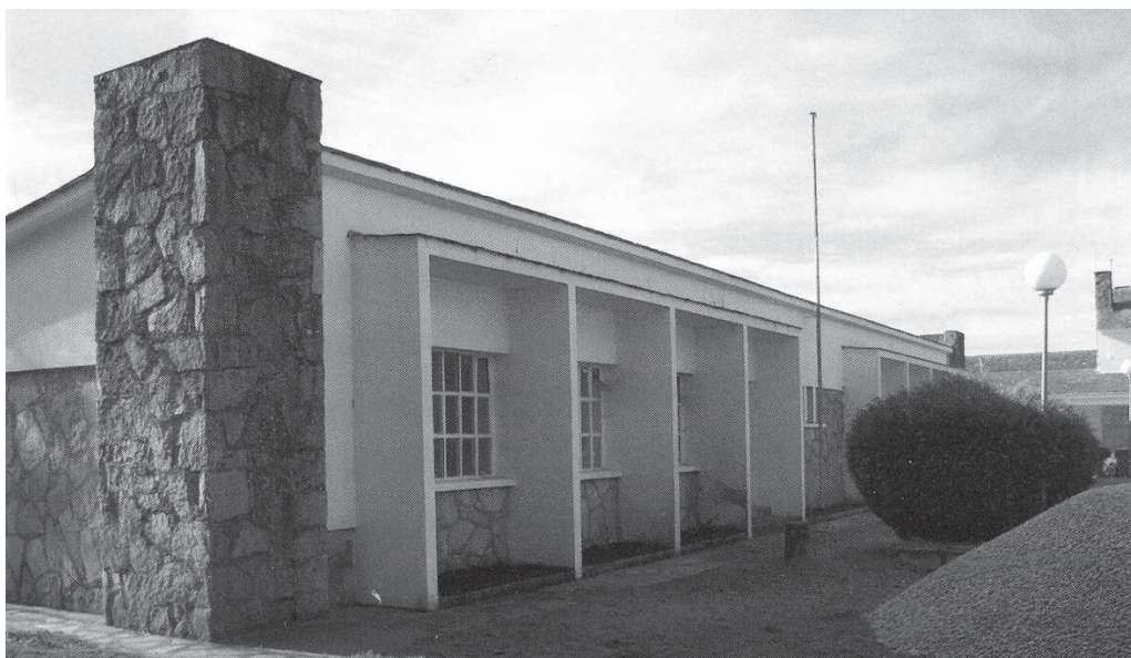
4-5 Odón Fernández Lavandera, Mariano Fernández Rico (Ingenieros agrónomos) y Santiago García Mesalles (Arquitecto), equipamientos del poblado de colonización de Matodoso (Castro de Rey, Lugo), 1956
