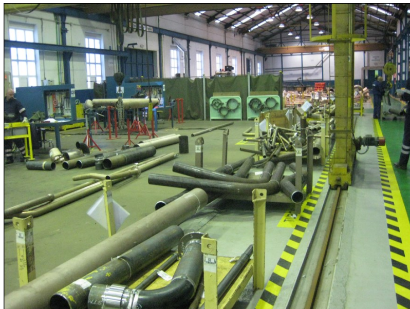
Ilustración 74. Área de almacenaje de tubos a la espera de ser transportados para su montaje
