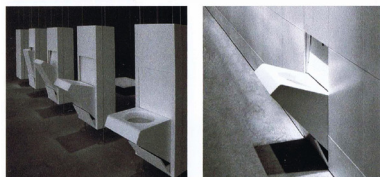
Fig. 3.2.12. Optimización del espacio en el edificio para personas mayores dependientes en Toulouse, 2009, RCR. Habitación tipo y WC retractil usado en el proyecto.
