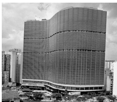
Fig. 3.1.05. Edificio Copan. Oscar Niemeyer, 1966. Sao Paulo (Brasil). 1106 viviendas.
