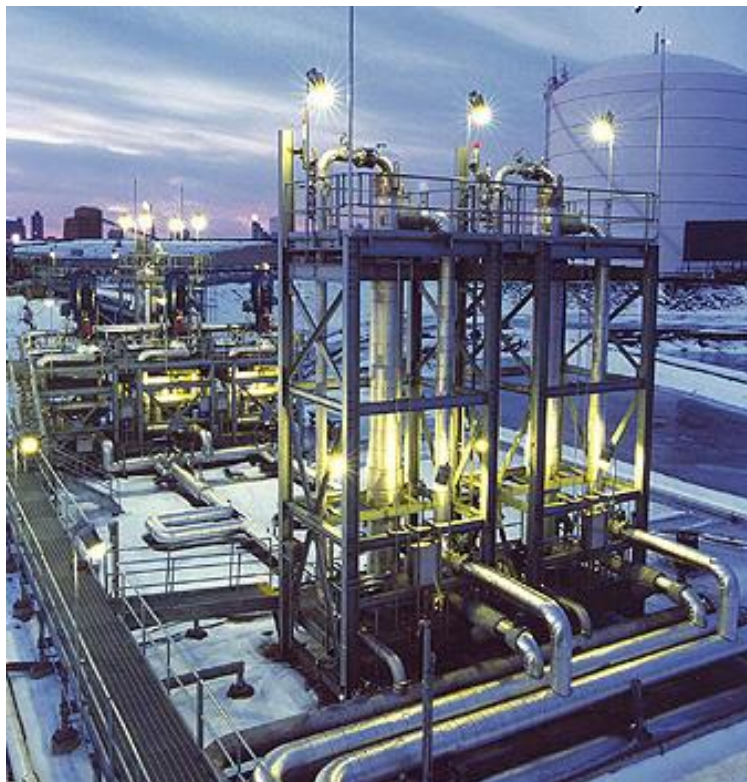
Figura 63: Ejemplo de vaporizadores verticales de gas natural de carcasa y tubos [ http://www.chicagopowerandprocess.com/LNG-vaporizers-cpp.html ]
