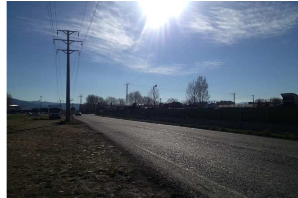
Poste línea eléctrica a soterrar
