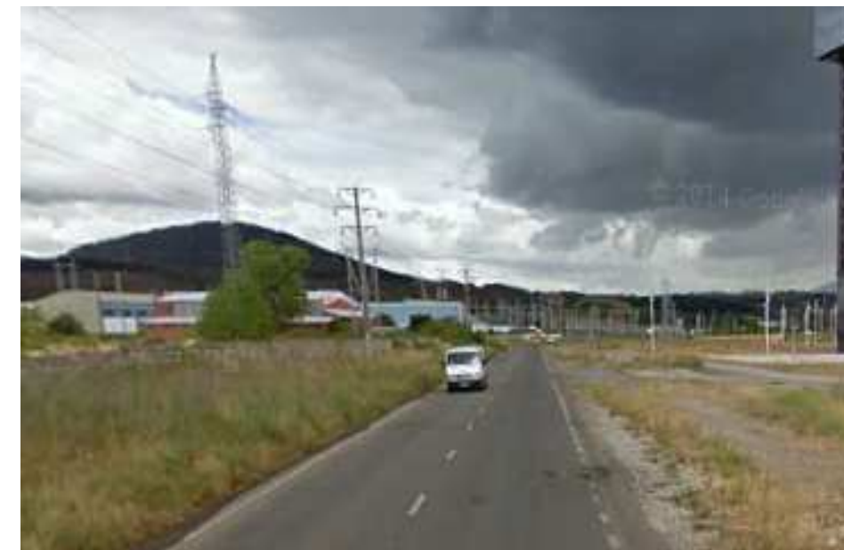
Vista actual del estado de la carretera
