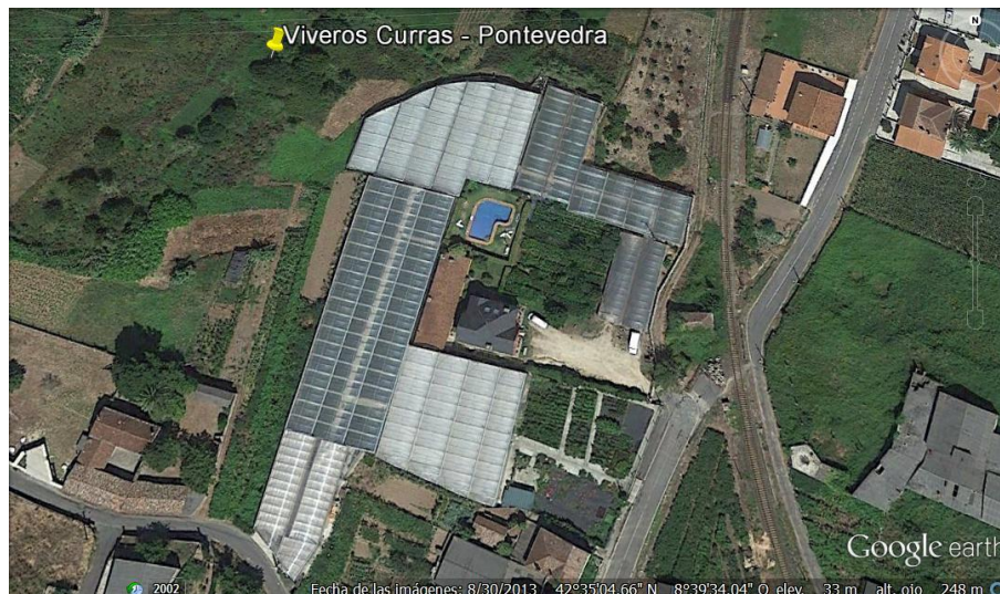
Figura 58. Vista aérea de las instalaciones de Viveros Curras – Portas - Pontevedra
