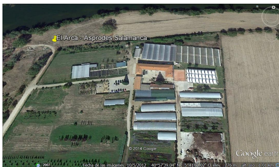
Figura 69. Vista aérea de las instalaciones de El Arca Asprodes - Salamanca
