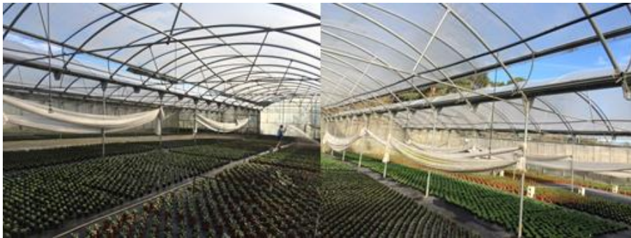
Figura 29. Instalaciones del invernadero frío
