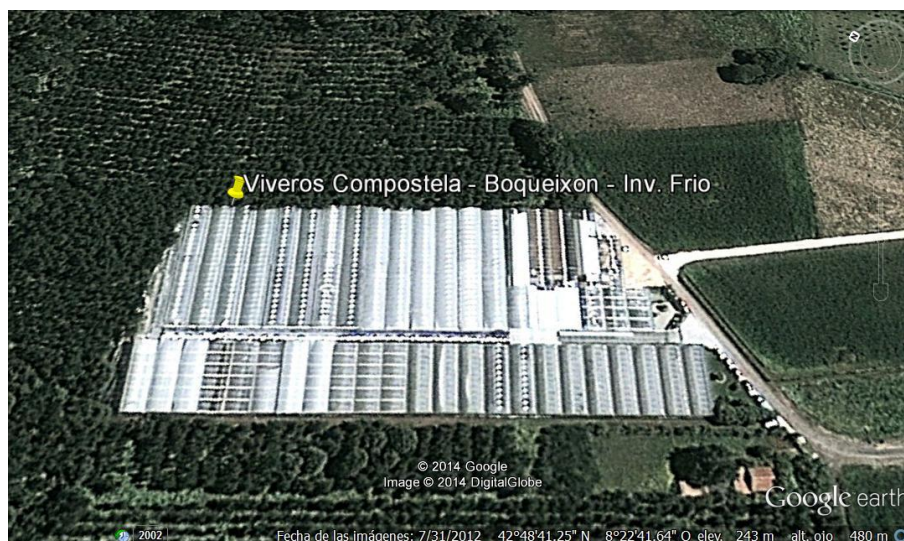
Figura 37. Vista aérea del Invernadero Frio de Viveros Compostela – Boqueixón – La Coruña
