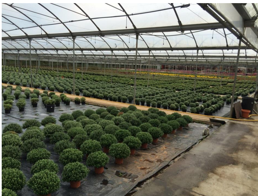
Figura 45. Instalaciones de producción invernadero frío
