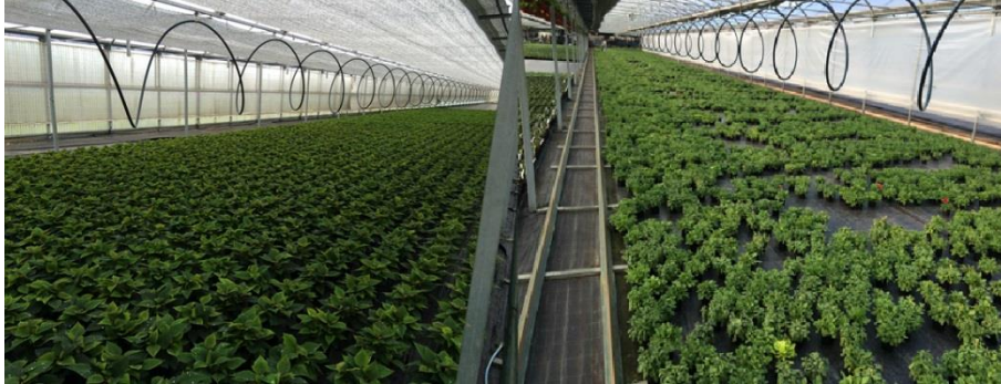
Figura 67. Vista general de la zona de producción detalle de las pantallas de sombreo y sistema de carro de riego.
