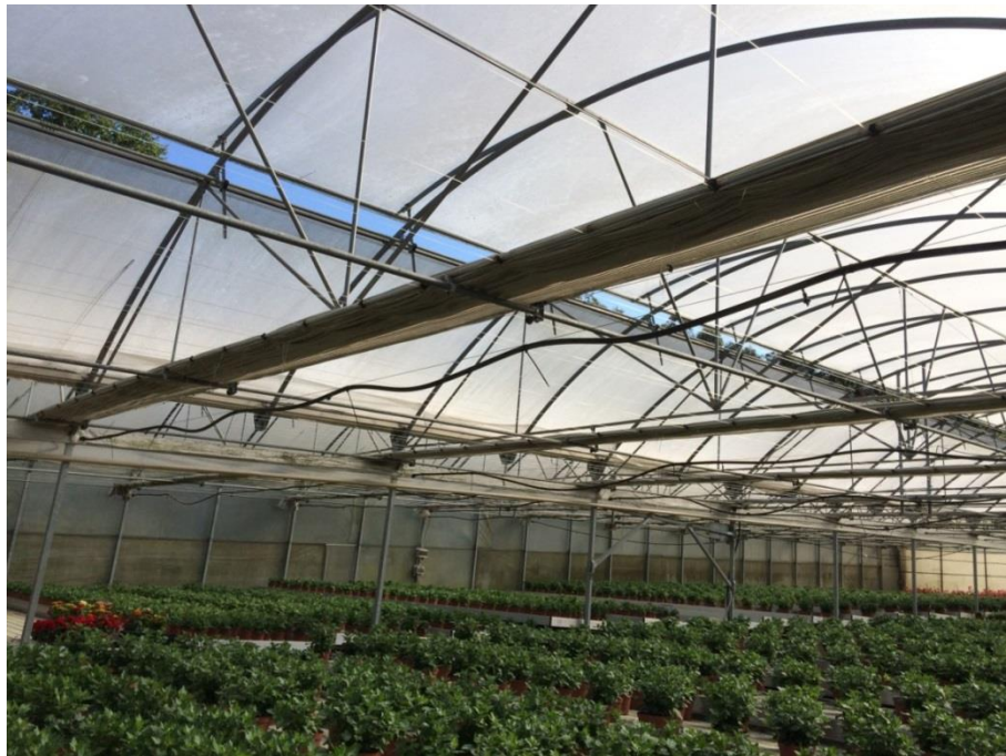
Figura 32. Detalle de la ventilación zenital y pantallas térmicas y de sombreo
