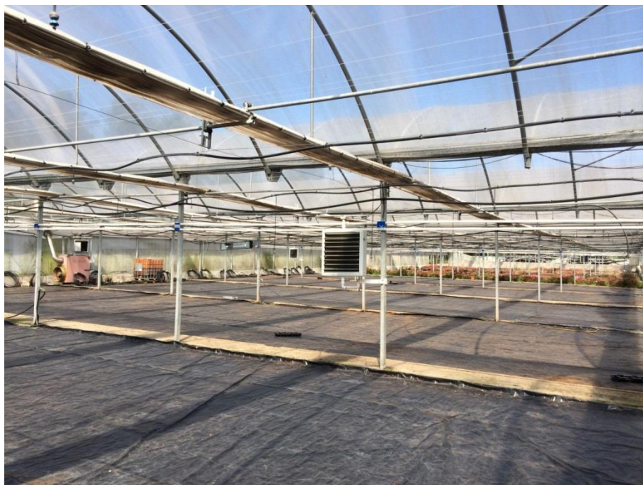
Figura 40. Instalaciones del invernadero normal. Detalle del sistema de calefacción y pantallas térmicas
