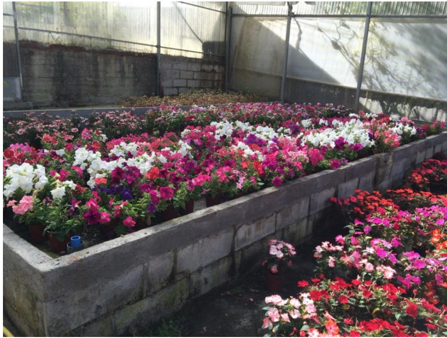
Figura 33. Producción en balsas de hormigón. Riego por inundación
