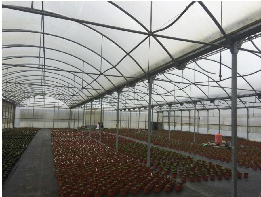
Figura 55. Vista general de las instalaciones de producción
