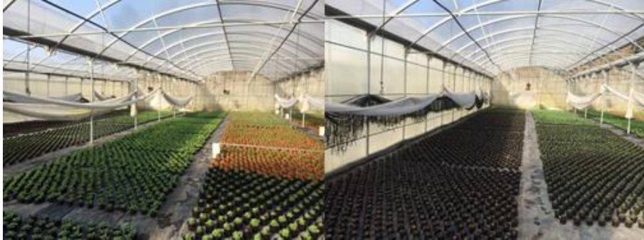
Figura 28. Instalaciones del invernadero caliente
