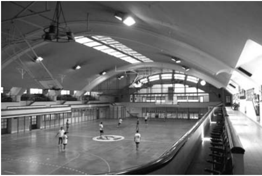
Figura 2 Escuela Naval de Marín: interior del gimnasio. Al fondo, la cristalera que separa el gimnasio de la piscina.
