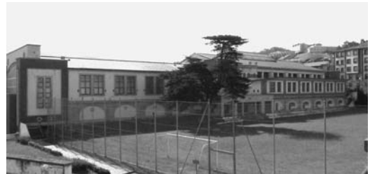
Figura 1 Escuela Naval de Marín: vista exterior del edificio del gimnasio-piscina. El volumen más bajo, a la izquierda, contiene la piscina, mientras que el cuerpo de la derecha alberga el gimnasio.
