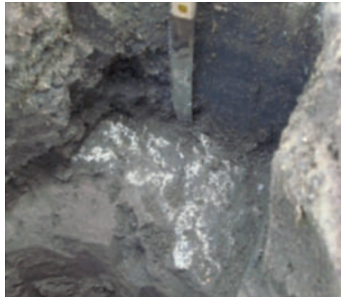
Figura B.5- Eflorescencia, subcapa compactada, corral 4 años de uso.
