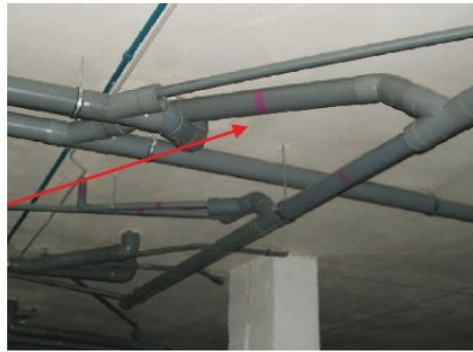
Imagen 2.16 Identificación de los puntos de suministro de AG o pluviales. Las tuberías que no suministren agua potable también deben ir marcadas
