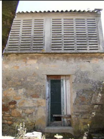
Fachada Noroeste hórreo
