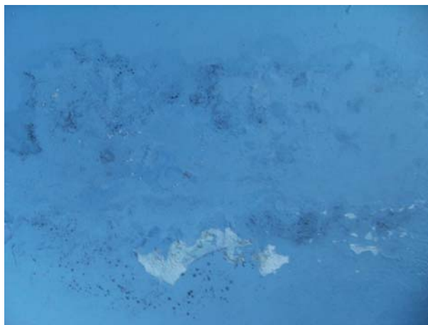
Figura 1.2.: Humedad de condensación
