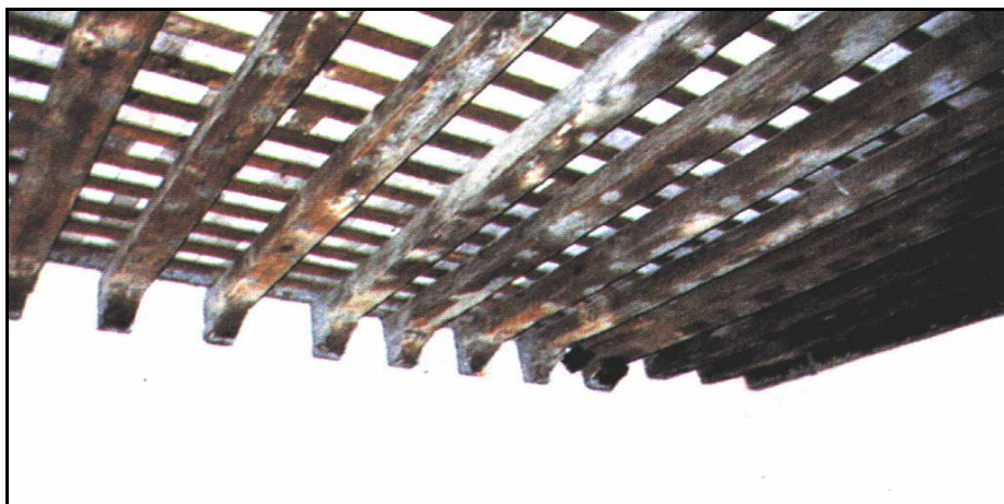
Figura 1.6.: Reparación por medio del sistema Beta
