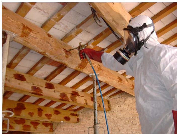
Figura 1.7.: Inyección de soluciones anti-xilófagos
