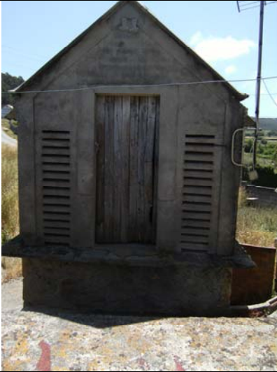
Fachada Noroeste hórreo
