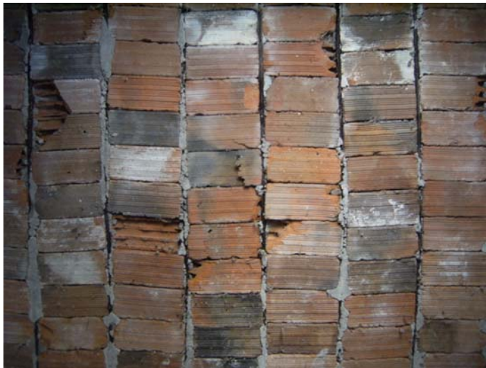
Figura 2.4.: Estructura de ladrillo con hierro enfoscado
