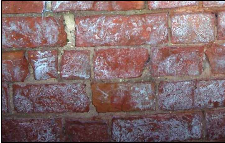
Figura 1.4.: Eflorescencias en fábrica de ladrillo
