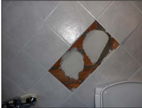
Figura 1.3.: Desprendimiento de alicatado
