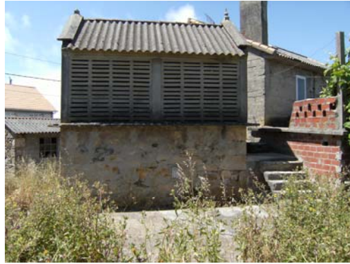
Fachada Sureste hórreo
