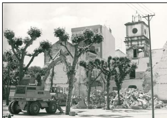
Figura 1.8.: Demolición del antiguo ayuntamiento
