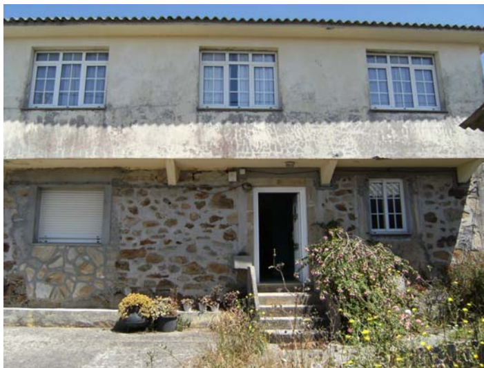
Figura 2.3.: Fachada Noroeste y principal de la vivienda
