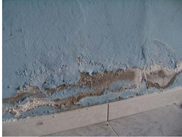
Figura 1.1.: Humedad por capilaridad
