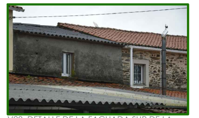
V28. DETALLE DE LA FACHADA SUR DE LA PLANTA PRIMERA
