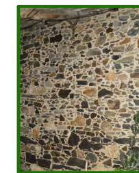
P4_PARAMENTO DE MAMPOSTERÍA
