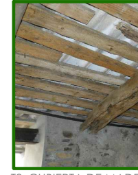
T3_CUBIERTA DE MADERA Y FIBROCEMENTO
