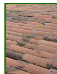
C2_CUBRICIÓN CON TEJA CERÁMICA CURVA
