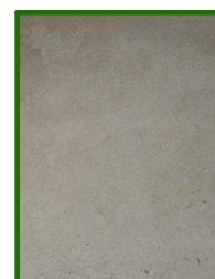
P1_ENFOSCADO DE CEMENTO
