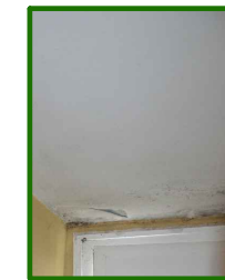
T4_TECHO DE PINTURA PLÁSTICA
