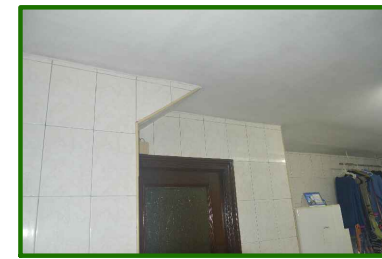
V5_FORJADO DE SUELO PLANTA PRIMERA CON EL ENCUESTRO DE LAS ESCALERAS CON ESTE.
