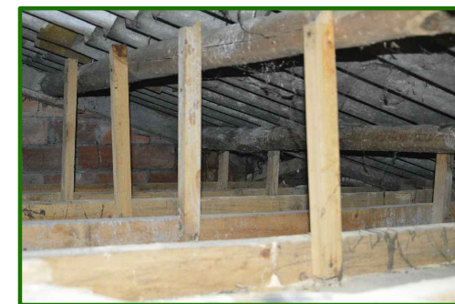
V19. DETALLE DE ESTRUCTURA DEL FALSO TECHO
