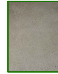
P1_ENFOSCADO DE CEMENTO
