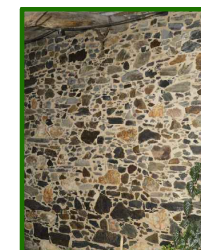
P4_PARAMENTO DE MAMPOSTERÍA
