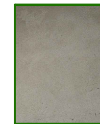
P1_ENFOSCADO DE CEMENTO
