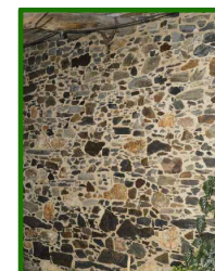
P4_PARAMENTO DE MAMPOSTERÍA
