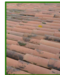
C2_CUBRICIÓN CON TEJA CERÁMICA CURVA
