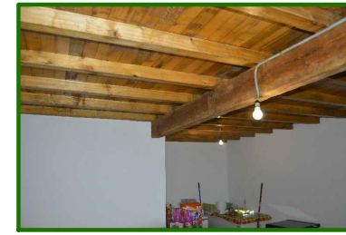
V1_ENTRAMADO DEL SUELO DEL ALMACÉN 3
