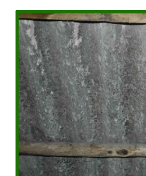
T2_CUBIERTA DE FIBROCEMENTO
