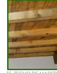
T5_TECHO DE MADERA
