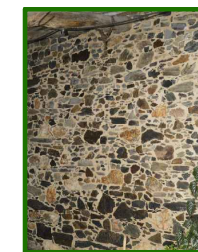
P4_PARAMENTO DE MAMPOSTERÍA
