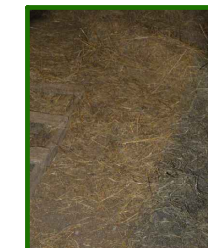
S2_SUELO DE TIERRA
