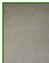
P1_ENFOSCADO DE CEMENTO
