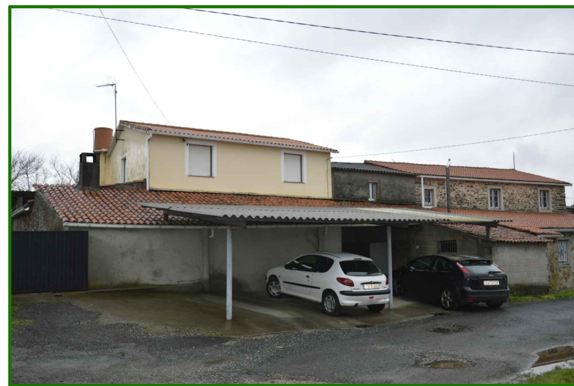
V23. FACHADA SUR DE LA VIVIENDA.
