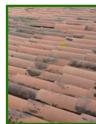
C2_CUBRICIÓN CON TEJA CERÁMICA CURVA
