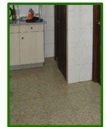
S4_PAVIMENTO DE TERRAZO
