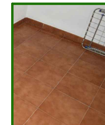
S3_PAVIMENTO DE GRES PORCELÁNICO
