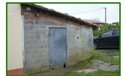
V37. FACHADA NORTE DE ALMACÉN 2
