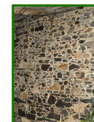
P4_PARAMENTO DE MAMPOSTERÍA
