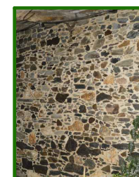
P4_PARAMENTO DE MAMPOSTERÍA
