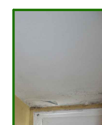
T4_TECHO DE PINTURA PLÁSTICA
