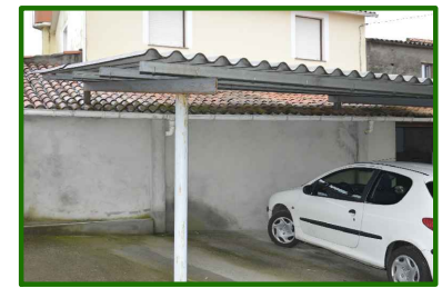
V6_ESTRUCTURA METÁLICA DE LA CUBIERTA DEL APARCAMIENTO.
