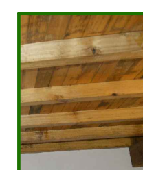
T5_TECHO DE MADERA
