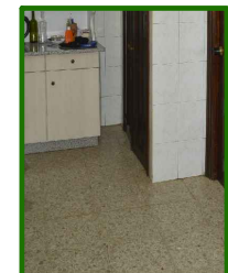
S4_PAVIMENTO DE TERRAZO
