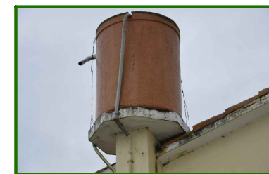
V30. DETALLE DEL DEPÓSITO DE AGUA
