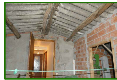
V4_CUMBRERA DEL ENTRAMADO DE VIGAS DE LA CUBIERTA DEL ALMACÉN 3.
