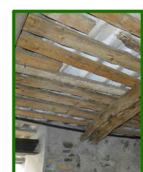
T3_CUBIERTA DE MADERA Y FIBROCEMENTO
