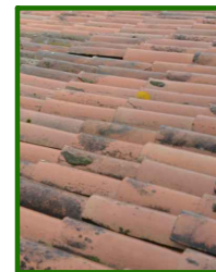
C2_CUBRICIÓN CON TEJA CERÁMICA CURVA
