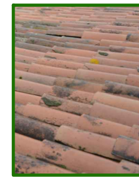
C2_CUBRICIÓN CON TEJA CERÁMICA CURVA
