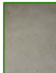
P1_ENFOSCADO DE CEMENTO
