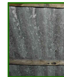
T2_CUBIERTA DE FIBROCEMENTO
