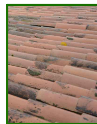
C2_CUBRICIÓN CON TEJA CERÁMICA CURVA
