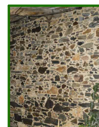
P4_PARAMENTO DE MAMPOSTERÍA
