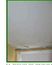
T4_TECHO DE PINTURA PLÁSTICA
