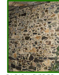
P4_PARAMENTO DE MAMPOSTERÍA
