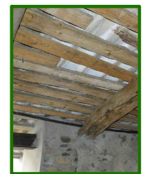
T3_CUBIERTA DE MADERA Y FIBROCEMENTO
