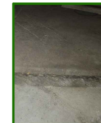
S1_SUELO DE CEMENTO MAESTREADO
