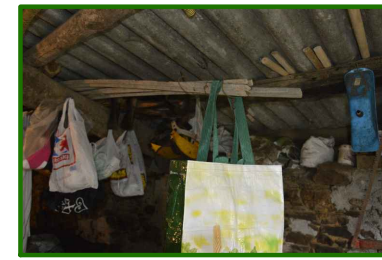
V3_ENTRAMADO DE VIGAS DE LA CUBIERTA DEL ALMACÉN 2
