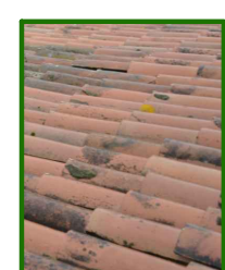
C2_CUBRICIÓN CON TEJA CERÁMICA CURVA
