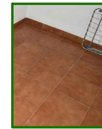
S3_PAVIMENTO DE GRES PORCELÁNICO
