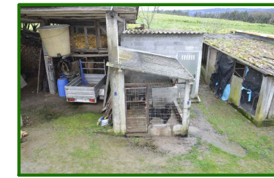
V1_VISTA GENERAL DE LOS ANEXOS
