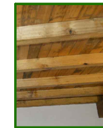
T5_TECHO DE MADERA
