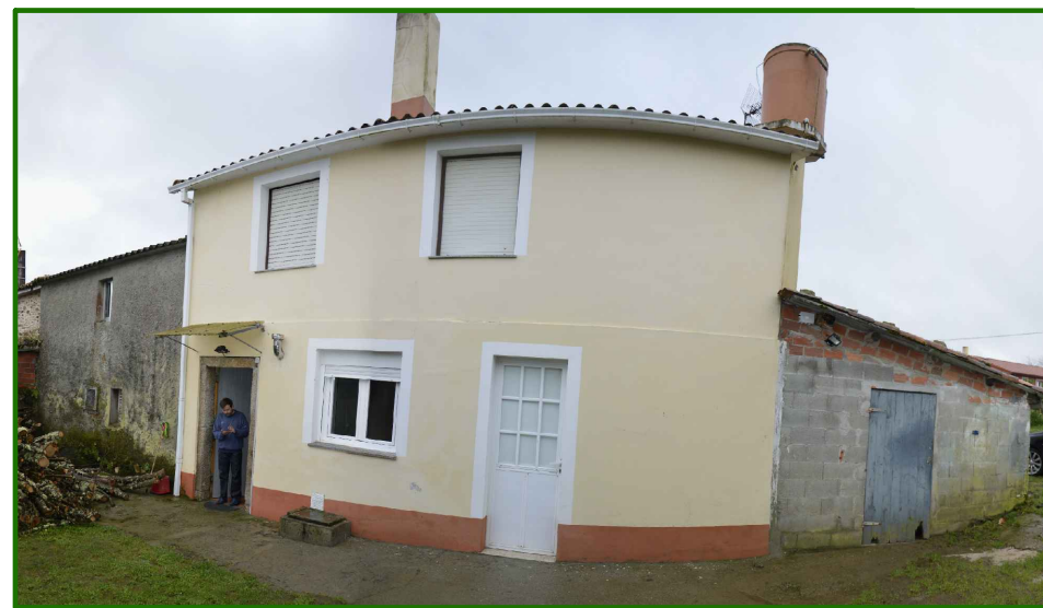
V34. FACHADA NORTE DE LA VIVIENDA.
