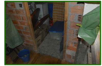
V2_FORJADO DE HORMIGÓN DEL BAÑO EN OBRAS
