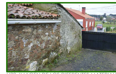
V32. IMAGEN DE LOS DIFERENTES MATERIALES DE LA FACHADA
