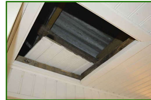
V17. ACCESO A ESTRUCTURA DE CUBIERTA
