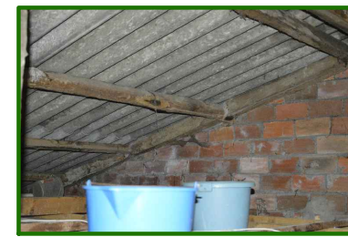
V3_ENCUESTRO DE LAS VIGAS CON LA FÁBRICA DE LADRILLO
