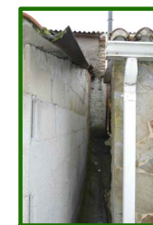
V25. HUECO ENTRE VIVIENDAS.
