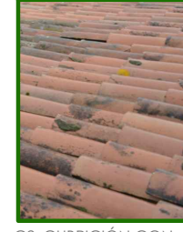
C2_CUBRICIÓN CON TEJA CERÁMICA CURVA
