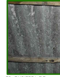
T2_CUBIERTA DE FIBROCEMENTO
