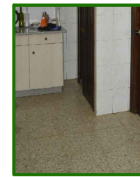
S4_PAVIMENTO DE TERRAZO
