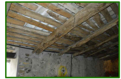
V4_ENTRAMADO DE VIGAS DE LA CUBIERTA DEL PORCHE DE ENTRADA
