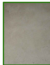
P1_ENFOSCADO DE CEMENTO
