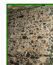
P4_PARAMENTO DE MAMPOSTERÍA
