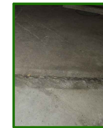
S1_SUELO DE CEMENTO MAESTREADO
