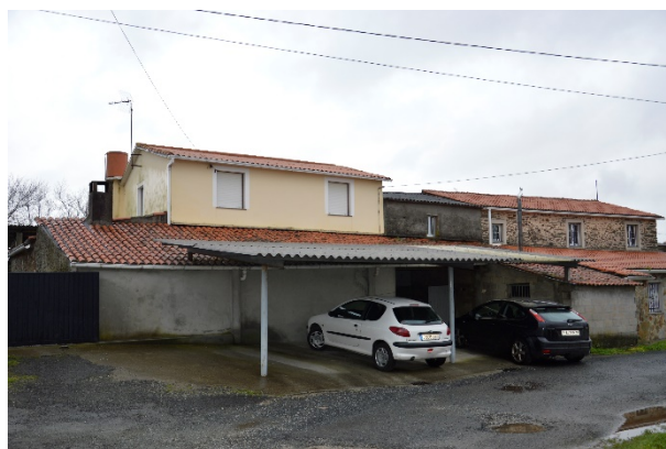
Imágen 1. Fachada sur de la vivienda actual
