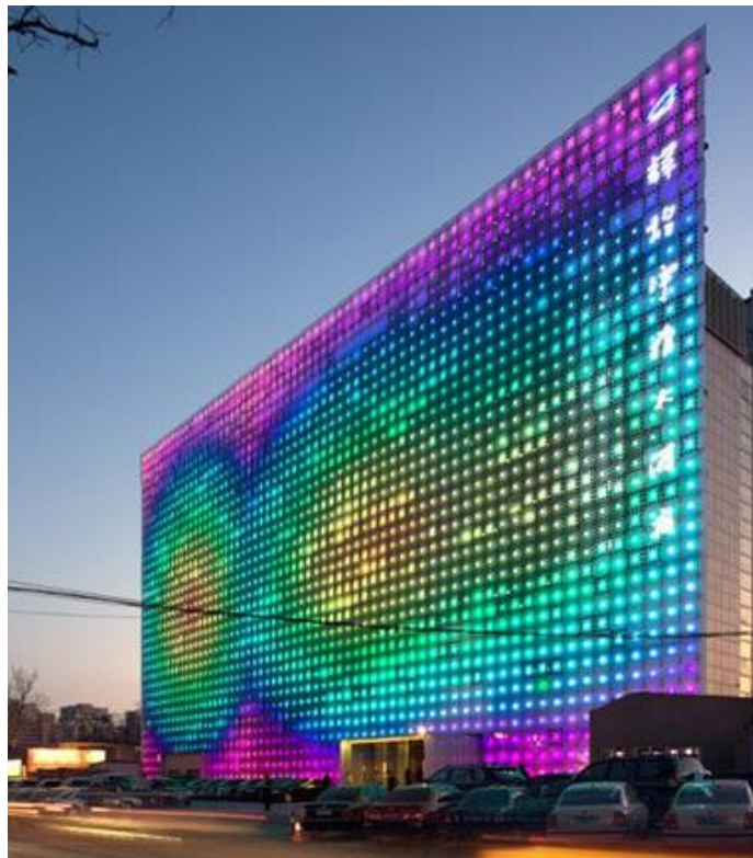
Ilustración 105. La Zero Energy Media Wall. Xicui Fuente: http://goo.gl/JNO1gh (Recuperado 11 Mayo 2015)
