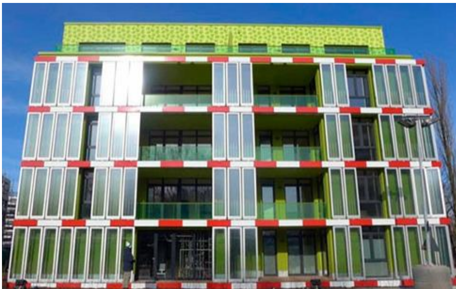
Ilustración 109. Edificio Bio Intelligent Quotient
