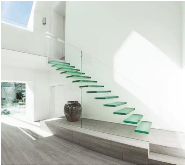
Ilustración 95. Escaleras de vidrio
