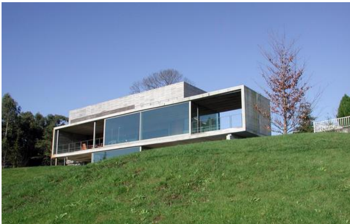
Ilustración 136. Casa en Perbes Fuente: (Recuperado 22 Mayo 2015)
