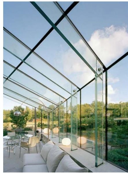
Ilustración 96. Vigas portantes de vidrio
