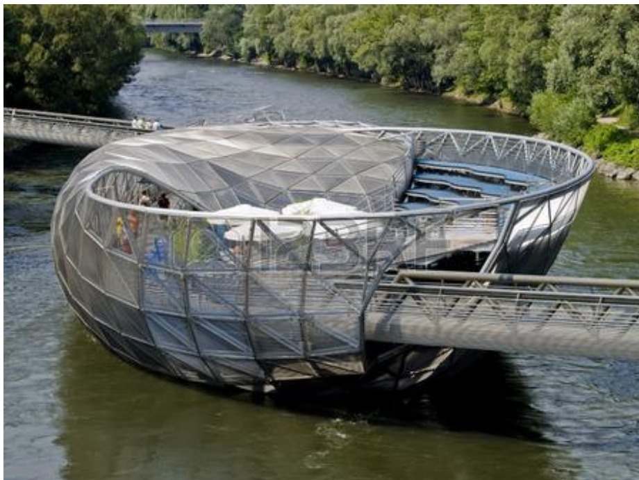
Ilustración 107. Puente Mur Island
