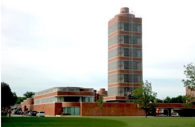
Ilustración 35. Johnson wax research tower Fuente: http://goo.gl/cWUpDs (Recuperado el 18 Marzo 2015)
