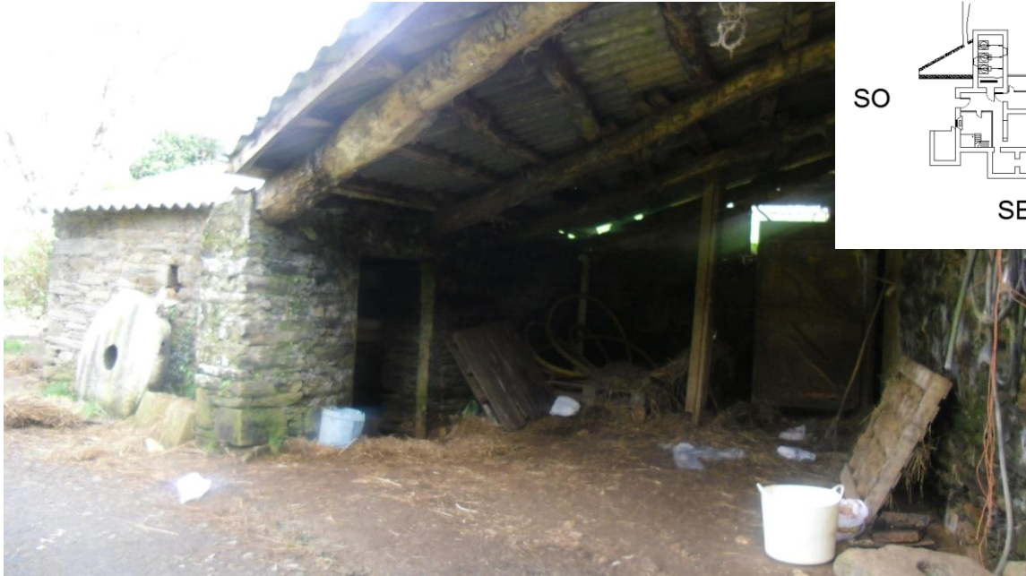
PUERTA DE ACCESO A HORNO, ALPENDRE 1 PLANTA BAJA
