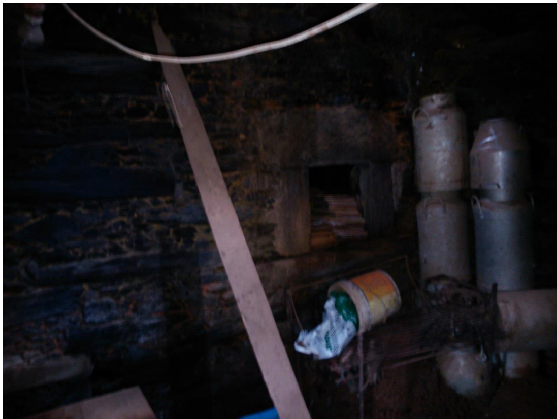
INTERIOR HORNO. FRENTE HUECO HORNO
