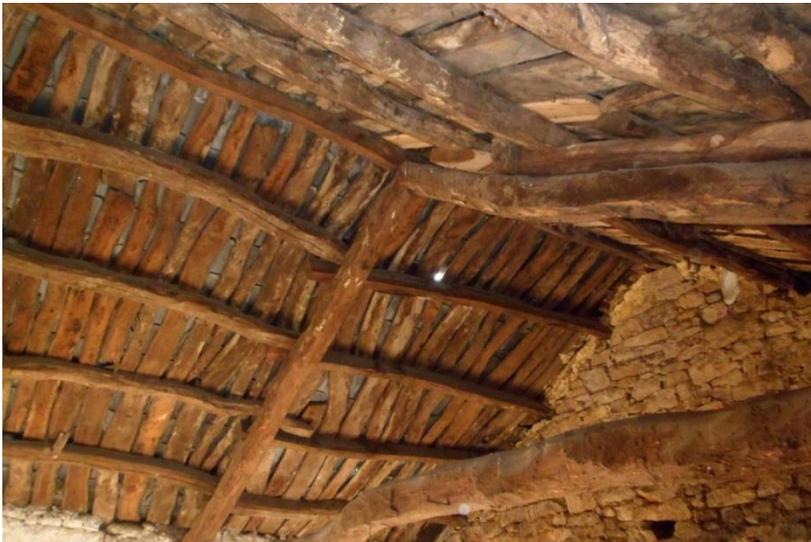
Fotografía del entramado de madera sobre el que se apoya la cubierta de pizarra
