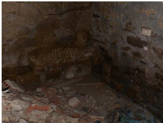
Humedad por capilaridad que se hace patente en la parte baja del muro
