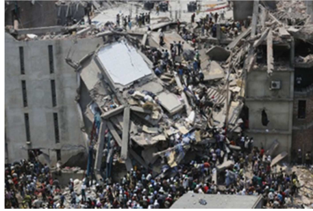
Figura 5: derrumbamiento del Rana Plaza
