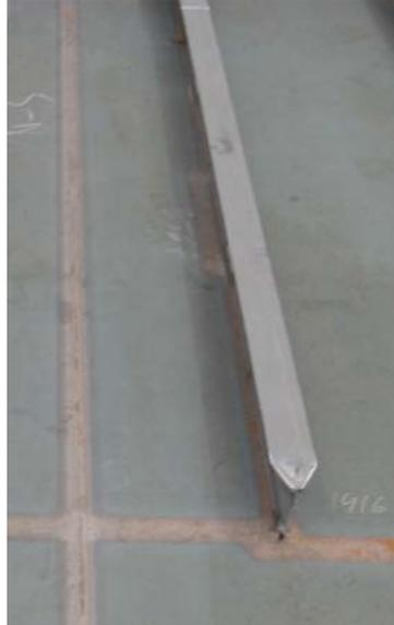
Figura 1.8.3.1 – Zonas chorreadas para colocación de elementos.
