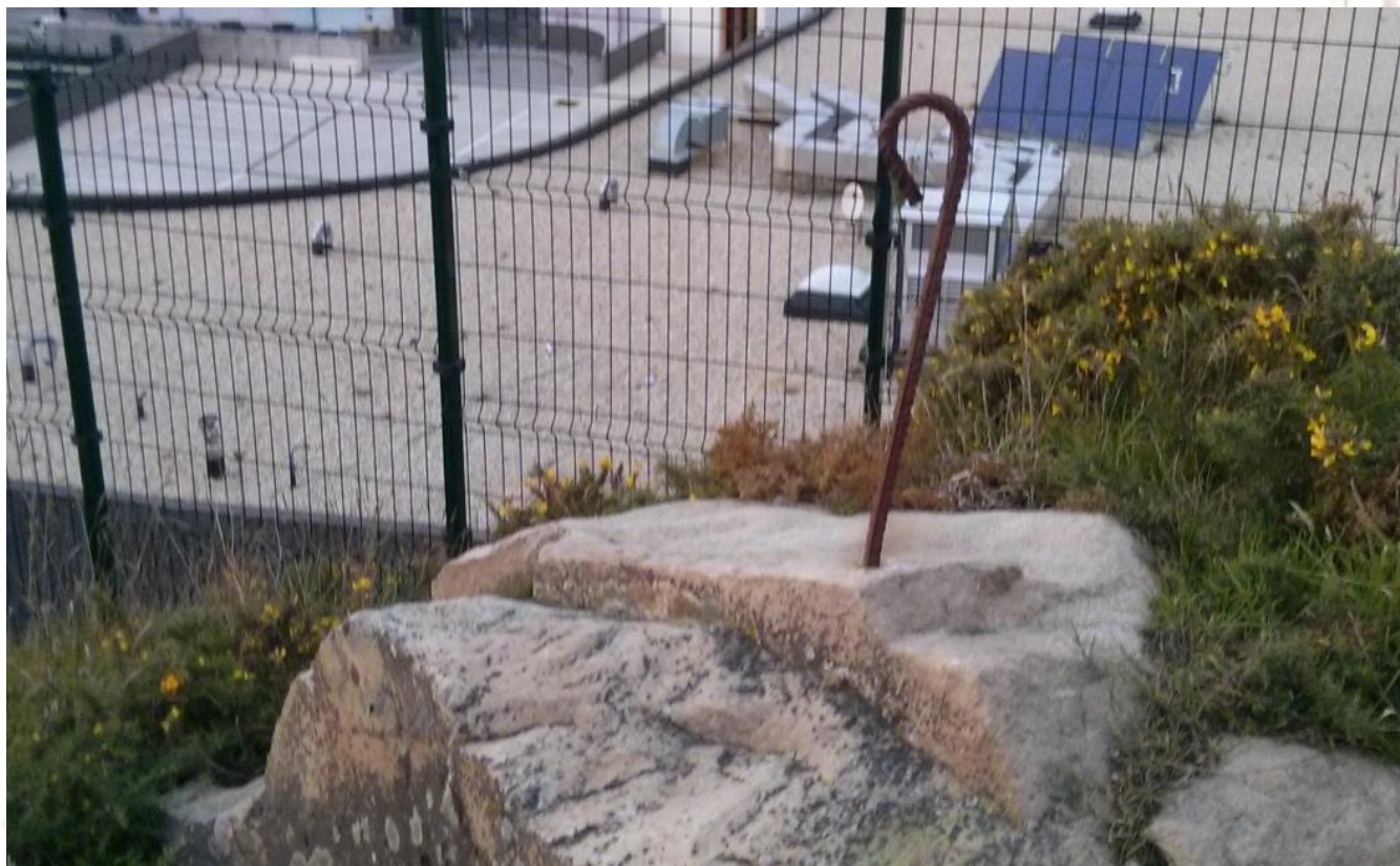
Fotografía A1.4: Ferralla al alcance de los transeúntes
