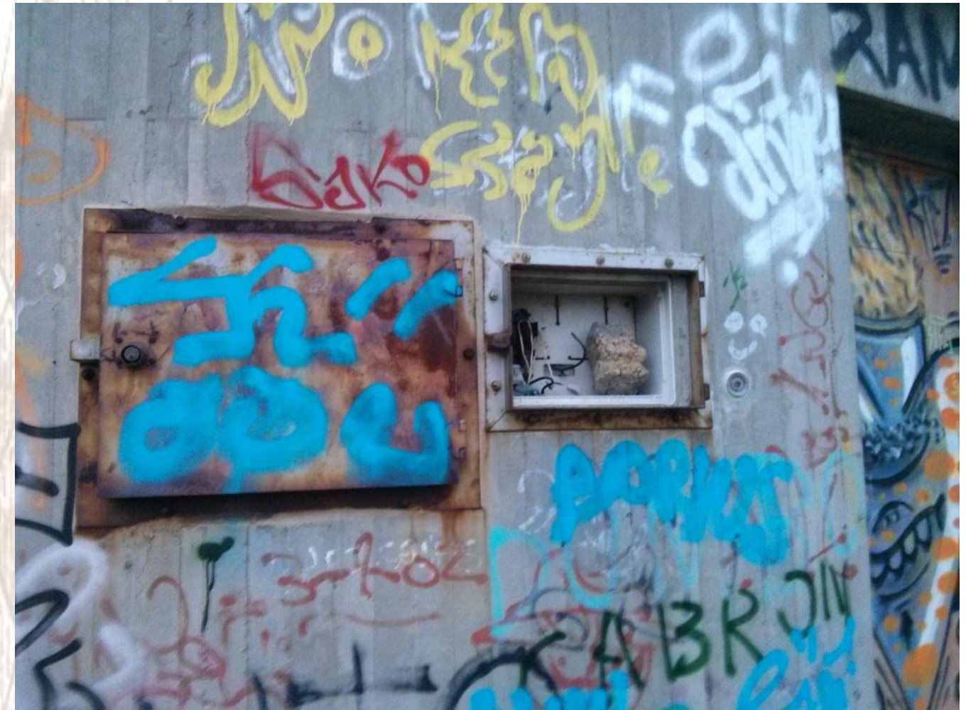
Fotografía A1.2: Elementos eléctricos a la vista y muy descuidados
