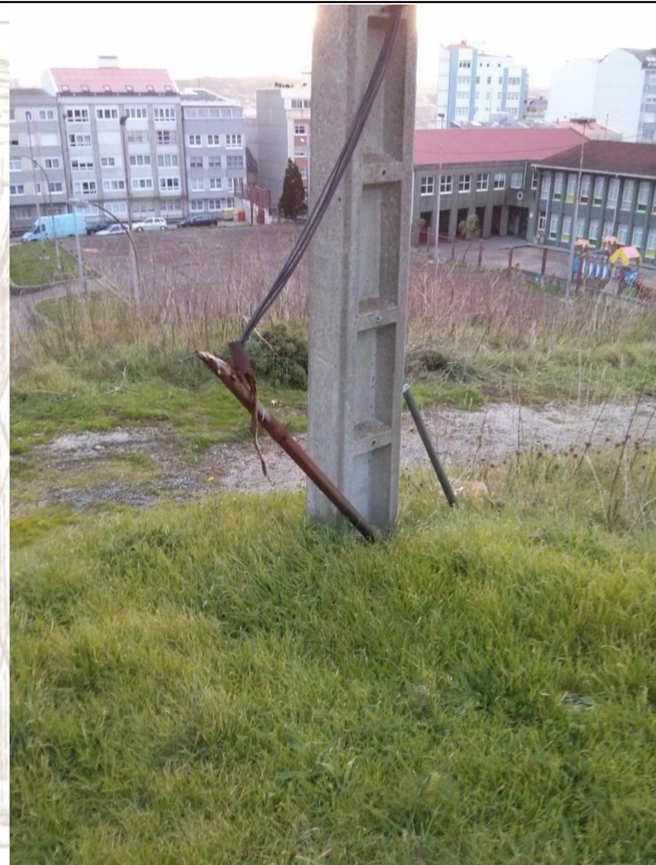
Fotografía A1.5: Poste de alumbrado no operativo en mal estado
