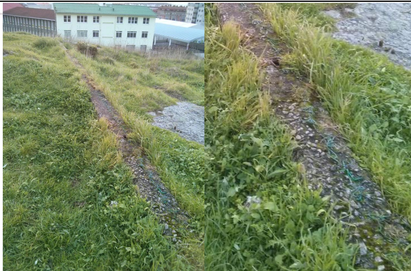
Fotografía A1.3: Restos de una verja indebidamente demolida, y detalle
