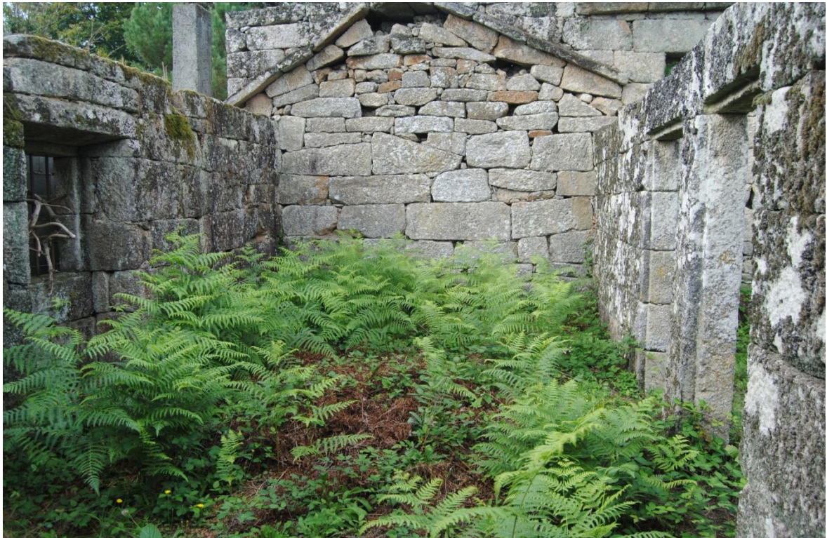
Zona Interior de la Edificación (Planta Primera - Nivel 01)
