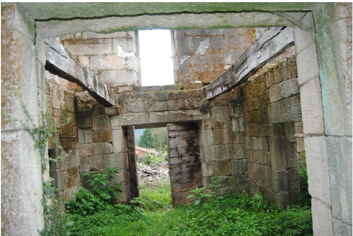
Zona Interior de la Edificación (Planta Baja - Nivel 00)
