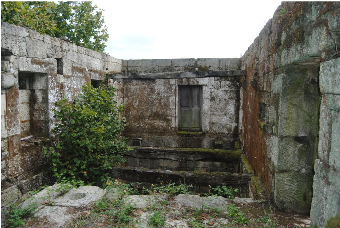
Zona Interior de la Edificación (Planta Primera - Nivel 01)
