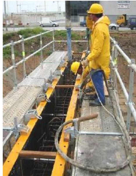
Figura 6.30b.- Encofrado vertical a una cara y a dos caras con medidas de protección incorporadas en el propio sistema.
