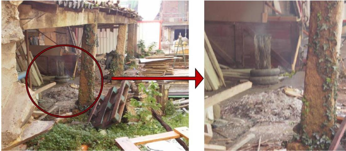
**Figura 6.32.- Condiciones pésimas de limpieza y riesgo de incendio. Obra nueva en Ares, A Coruña. Fuente propia.**
