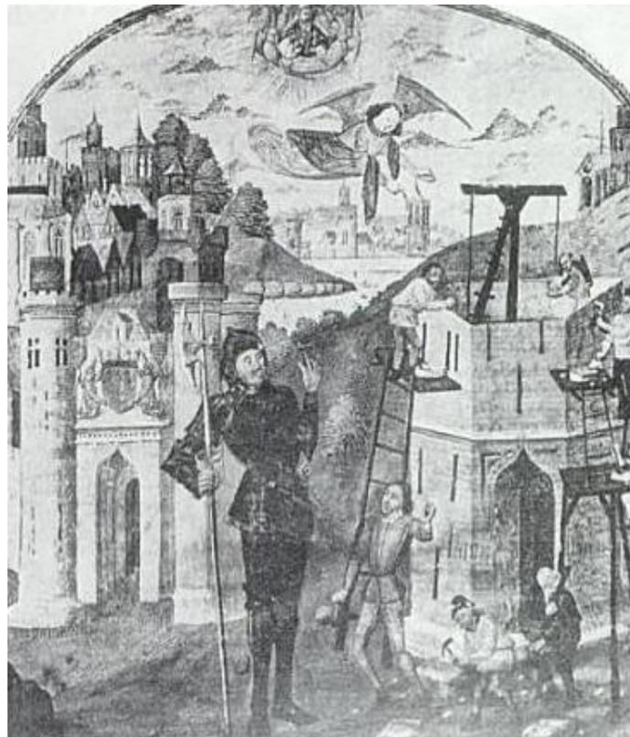
Figura 4.6.- Grúa de eje arriostrado. Miniatura de la construcción de la Torre de Babel, h. 1430. Gabinete de las Estampas de Berlín.
