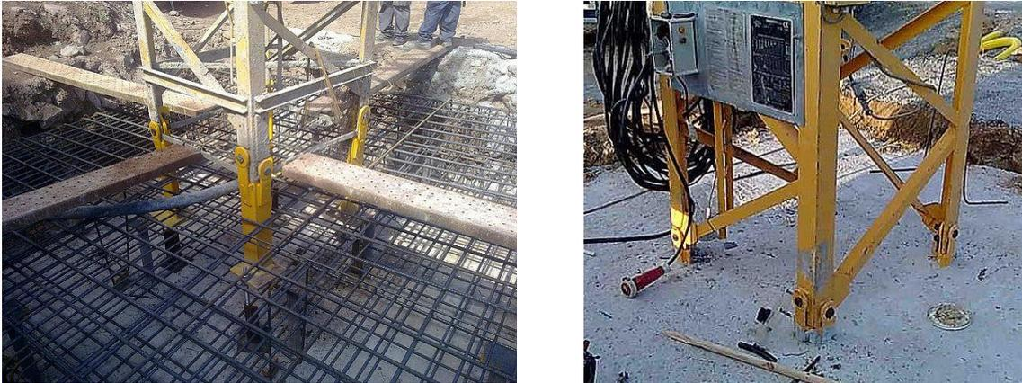
Figura 6.29.- Grúa torre anclada en hormigón.
