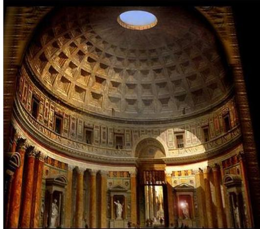
**Figura 3.2.- Cúpula de hormigón del Panteón de Agripa**
