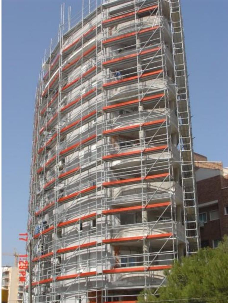
Figura 6.9.- Andamio tubular multidireccional con sistema ADAPT. Protección colectiva.
