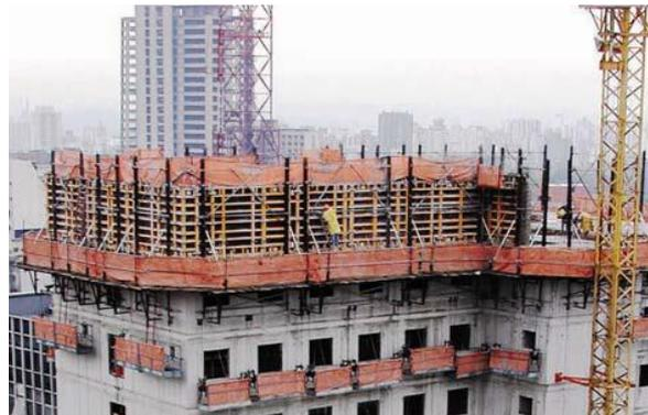
Figura 6.30c.- Sistema de encofrado trepante con protecciones perimetrales integradas.
