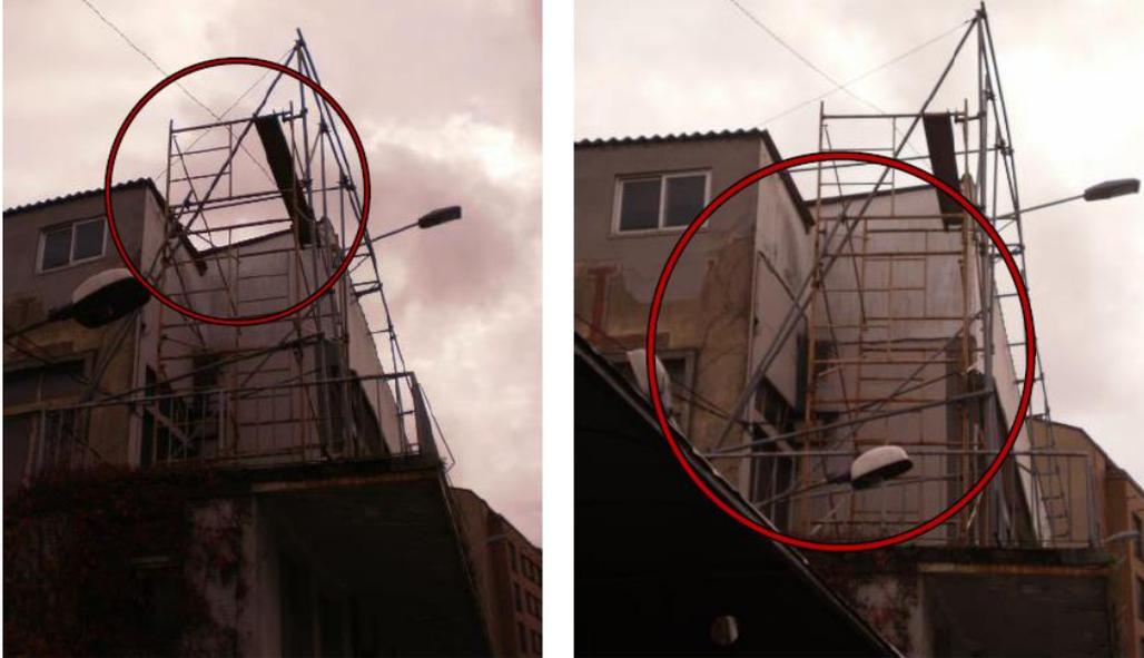
**Figura 6.35.- Riesgo de derrumbamiento del andamio. Obra de reforma en El Seijal, Cambre (A Coruña). Fuente propia.**
