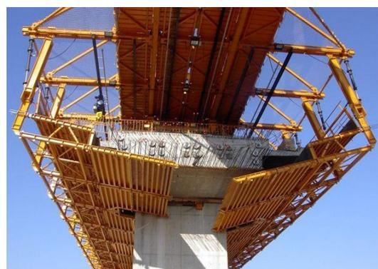
Figura 6.30d.- Sistema de encofrado modular para ejecución de puentes con seguridad integrada.
