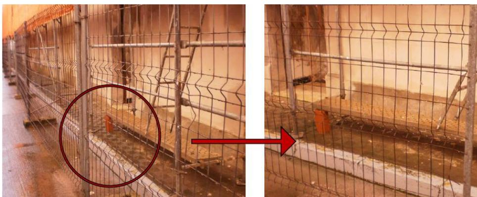
**Figura 6.34.- Riesgo por mal montaje de andamio. Obra de nueva construcción en Ares, A Coruña. Fuente propia.**
