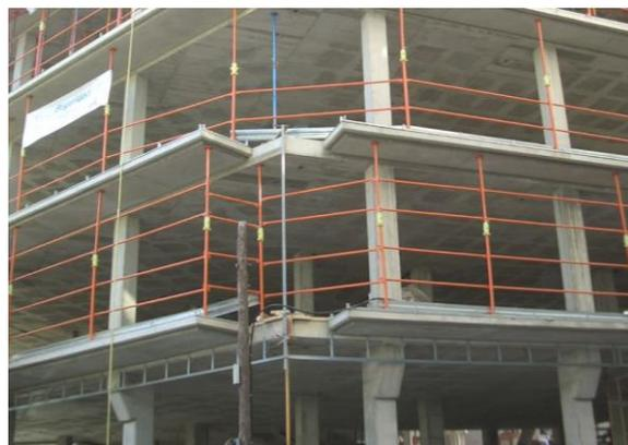
Figura 6.5a.- Sistema provisional de protección de huecos verticales mediante puntales telescópicos.<sup>182</sup>
