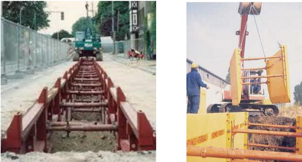
Figura 6.17.- Entibación de zanja mediante paneles de blindaje.
