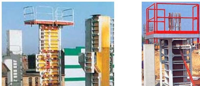
**Figura 6.30a.- Encofrado de un pilar con protección de plataforma de trabajo a base de barandillas.**
