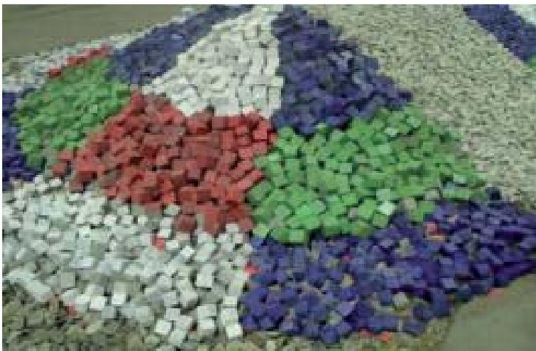
Figura 5.10. Morro del dique formado por cubos de hormigón pintados de colores por secciones y escollera de grava a continuación.
