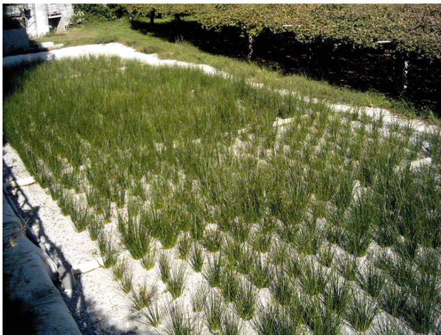
Foto 8-3: Foto de los humedales de flujo subsuperficial horizontal (FHSS 1, 2 e 3).
