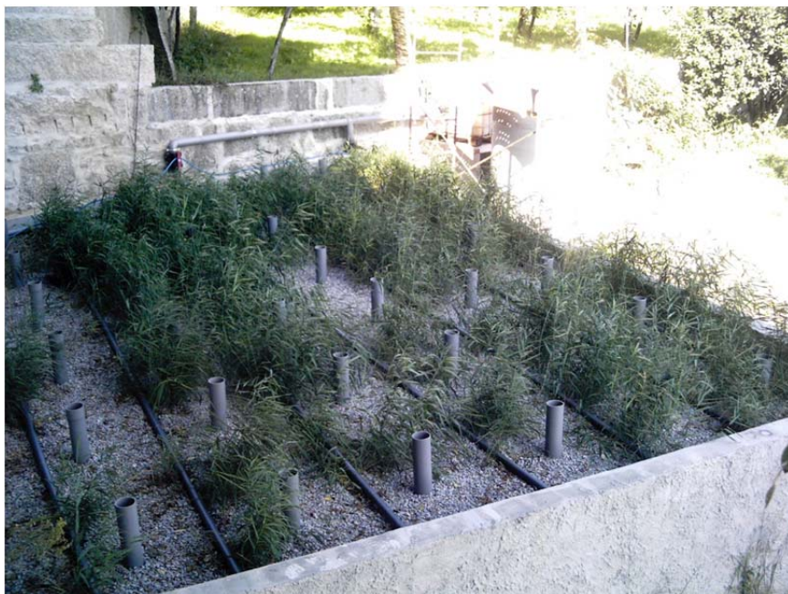
Foto 8-2: Foto del humedal de flujo subsuperficial vertical (FV).
