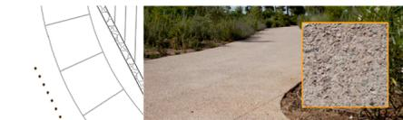
el pavimento debe de tener el mismo acabado en todos los solados exteriores e interiores, así como las rampas y escaleras-rampas.
