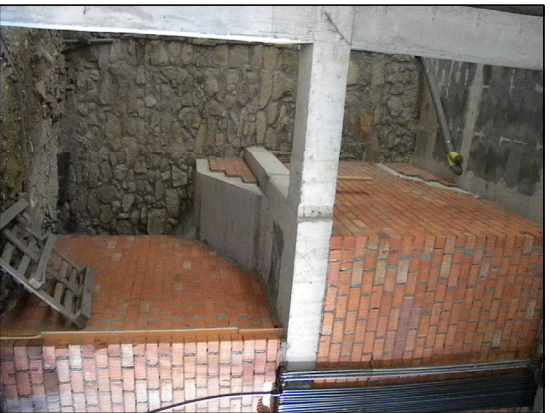
FOTO 3 – ESTRUCTURA ESCALERA Y VIGAS HORMIGÓN.
