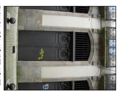
ELEMENTOS A CONSERVAR : SE MANTIENEN LOS TRAVESAÑOS, LOS BARROTES Y LAS MOLDURAS SUPERIORES DE TODAS LAS PUERTAS
