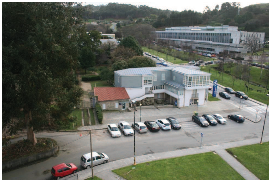
Fotografía: acceso por Camiño de O Lagar de Castro en la parte inferior, y acceso por Rúa Pena do Cuco a la derecha.
