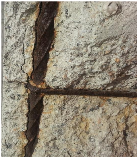
Ilustración 3.6. Armadura corroída.
