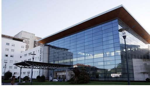
Figura 4. Hospital Arquitecto Marcide (Ferrol)
