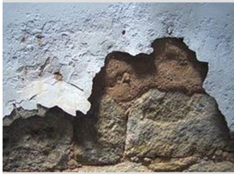
Imagen 2-5: Revestimiento de mortero de cemento sobre fábrica de mampostería ( https://idearqiberica.wordpress.com/tag/arquitectura-tradicional/ )
