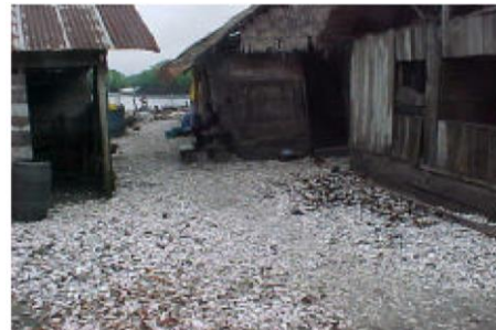
Imagen 2-26: Solera de hormigón con bígaro como árido grueso
