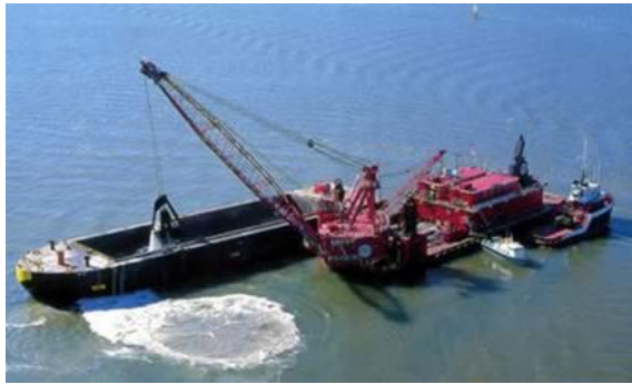
Imagen 2-15: Dragalina depositando arena del fondo marino en un barco de transporte ( http://www.marmaray.com )
