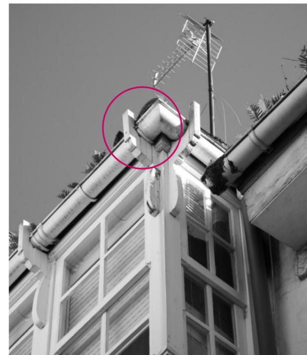
2\_ Elementos de sujeción del canalón en Rúa dos Lazos nº 6. Los elementos de sujeción realizados en madera parten de la galería.
