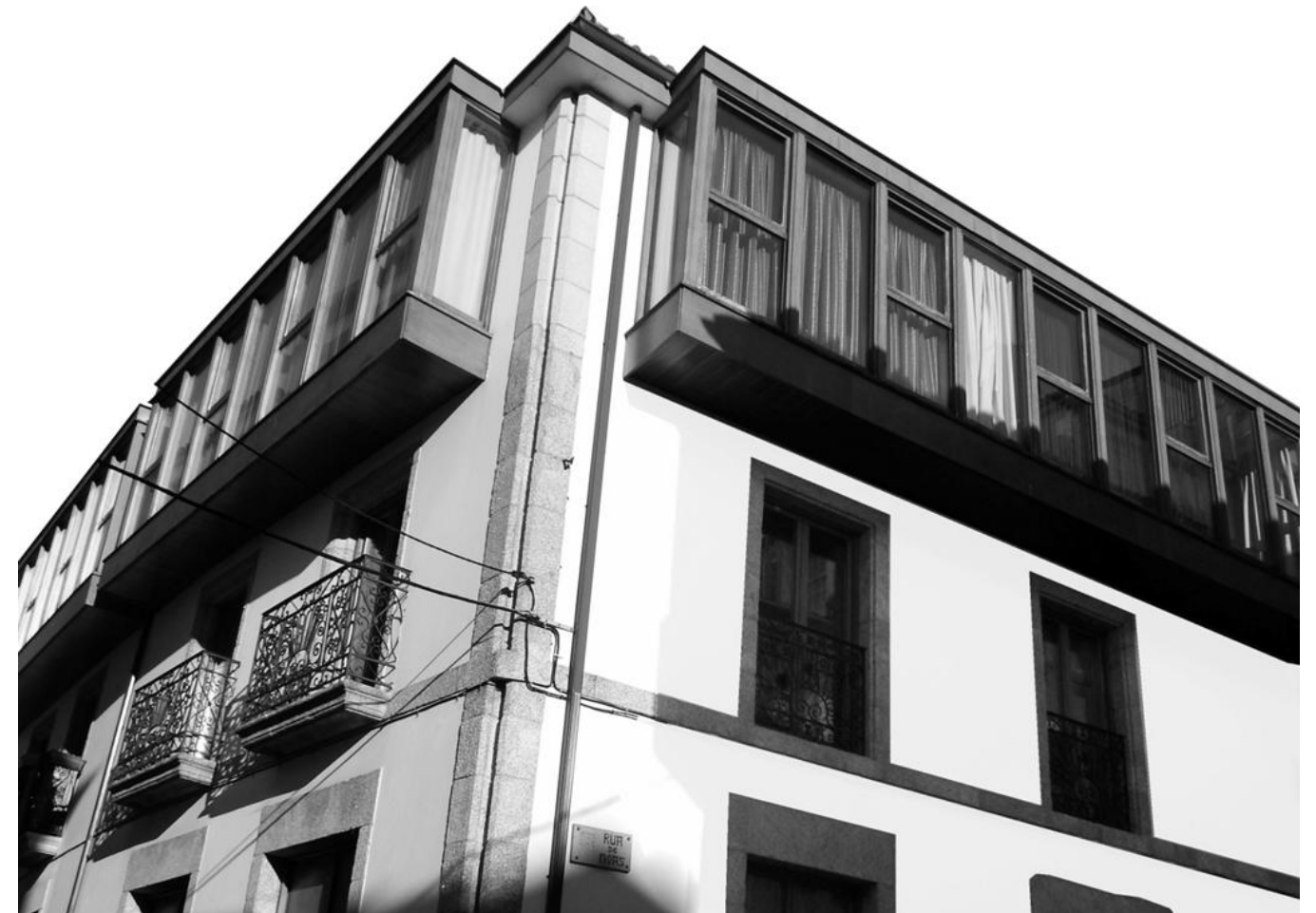
43_Galería actual. Calle San Francisco nº 31. Debido a su ubicación dentro de la zona protegida por el Plan Especial del Casco Histórico, se debe cumplir la normativa que trata la construcción de galerías que, al tratarse de una edificación nueva debe aportar soluciones que sean testimonio de la arquitectura actual pero respetando las proporciones generales de acristalamiento. Por tanto, creo que este sería un buen ejemplo de aplicación de la normativa actual
