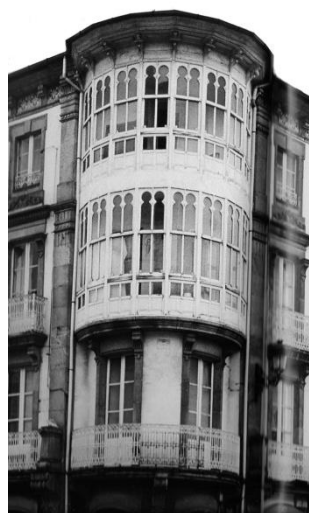
12 Detalle de la galería cilíndrica de la casa del Tambor. En la carpintería se realizaron arcos mudéjares.
