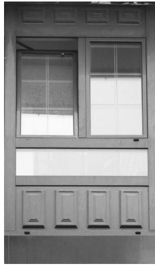
41 Detalle de bastidor de una galería actual que imita la tipología tradicional. El material es aluminio pintado de verde y las ventanas de guillotina se sustituyen por oscilobatientes.
