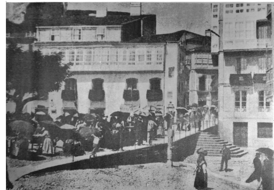
13 Plantas firmadas por Juan Álvarez de Mendoza para la vivienda situada en la Plaza de Arines nº 40 en 1903 y fotografía realizada por Ferrer en 1905 donde se puede ver la galería realizada en la planta segunda que fue eliminada para realizar el ensanche de la Puerta de la Villa.
