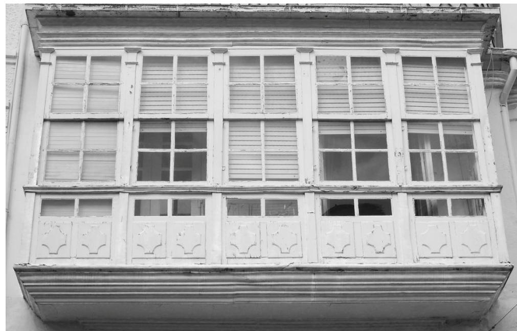
27_Galería tradicional. Rúa do Castro nº 25. La galería cuenta con una mínima ornamentación en las molduras de la repisa y la cornisa, además de la introducción de unos sencillos capiteles.
