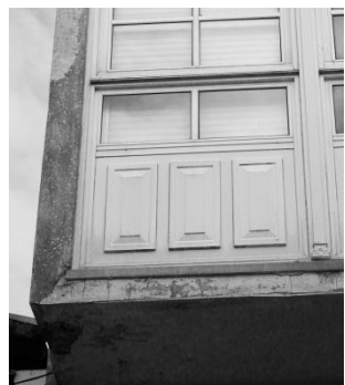
44_Una de las múltiples construcciones en voladizo que se han construido al amparo de la normativa siendo consideradas como galerías pero cuyos laterales macizos enmarcan el frente junto con las líneas de forjado.
