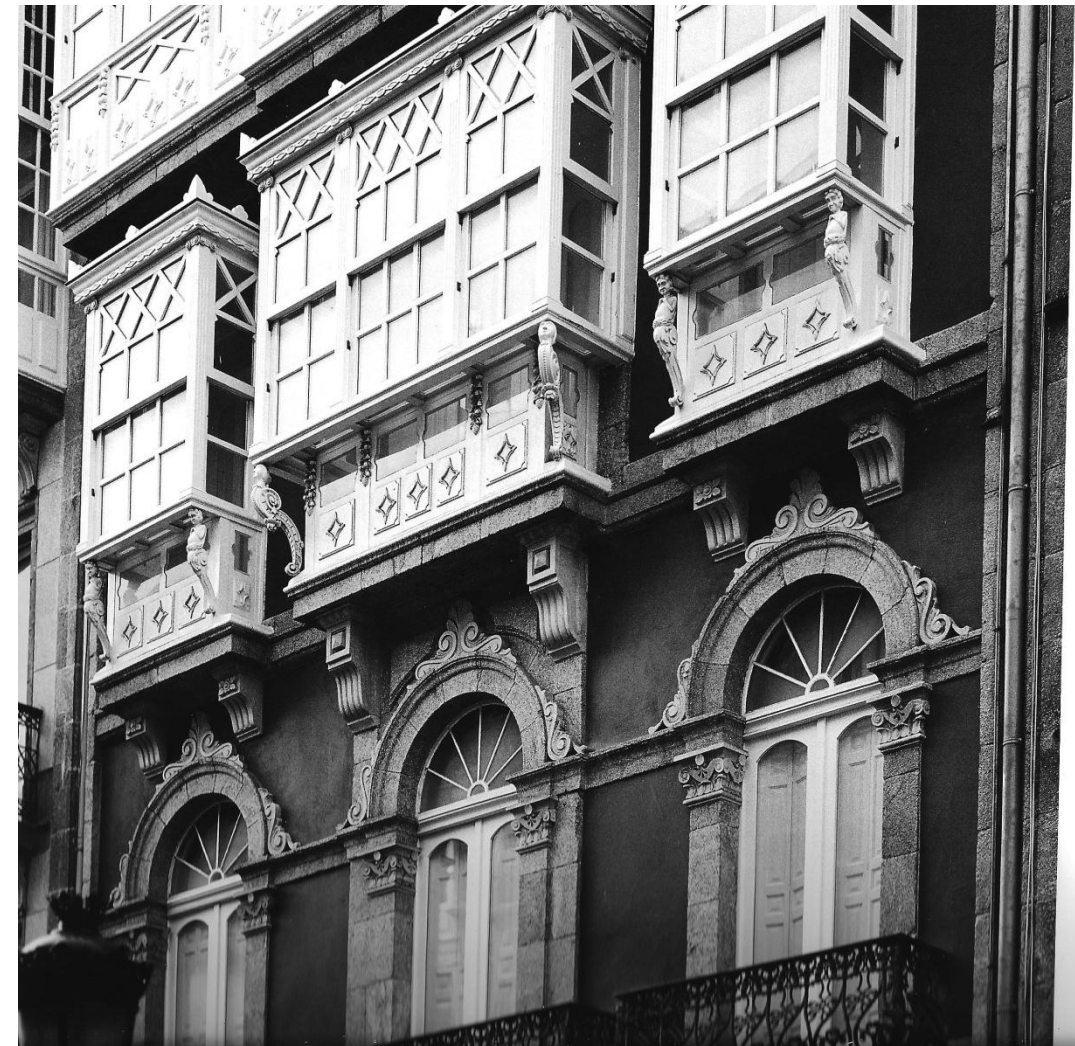
7 Miradores eclécticos de las viviendas de la calle Rego de Auga nº 31, Faustino Domínguez Domínguez, 1870. Las composiciones monótonas basadas en elementos decorativos académicos, como recomendaban las Ordenanzas de la Policía Urbana de 1854 de A Coruña, dejarán paso en los 70 a viviendas donde la ornamentación ganaba protagonismo como medio de transmitir el poder económico de sus propietarios.
