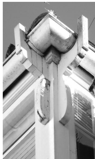
26_Las galerías tradicionales no cuentan apenas con ornamentación, los pocos detalles que surgen son funcionales como por ejemplo los soportes superiores que sustentan el canalón.
