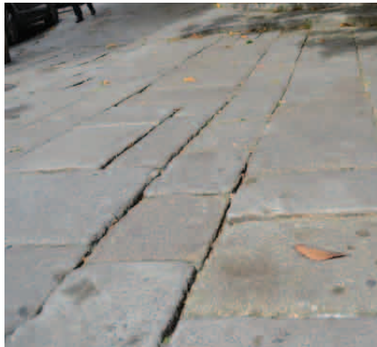
Fig. 346. Pequeños resaltes en pavimento (fuente propia)
