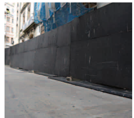
Fig. 377. Vallas de obras (fuente propia)
