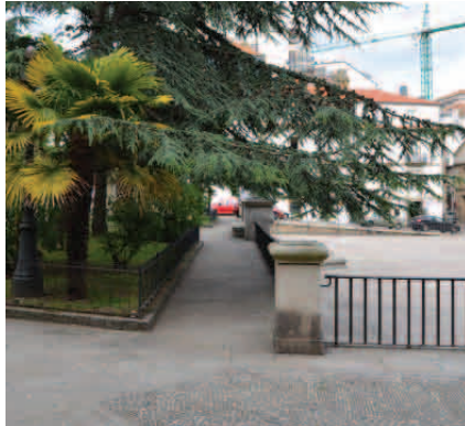
Fig. 355. Vegetación que invade el itinerario peatonal (fuente propia)
