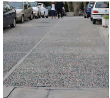
Fig. 359. Cambio de pavimento (fuente propia)
