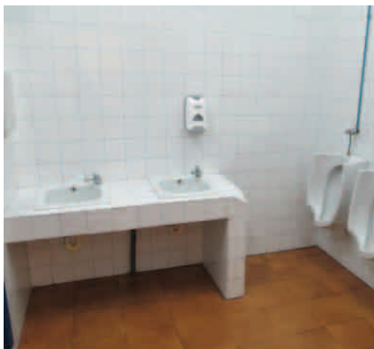
Fig. 411. Altura libre bajo el lavabo de 64cm (fuente propia)
