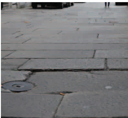
Fig. 363. Huecos, resaltes y piezas sueltas (fuente propia)
