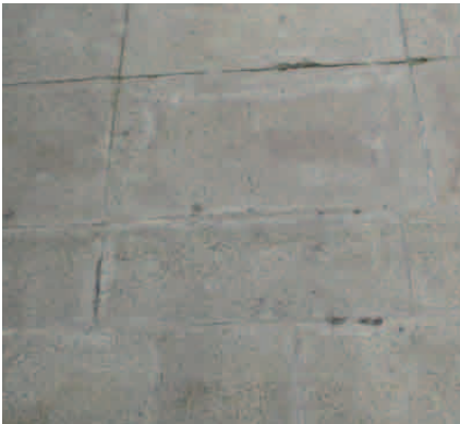
Fig. 345. Detalle del pavimento (fuente propia)
