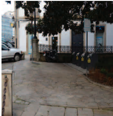
Fig. 343. Pequeños resaltes en pavimento y contenedores enterrados (fuente propia)
