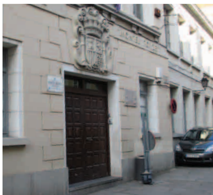
Fig. 396. Peldaño en el acceso (fuente propia)
