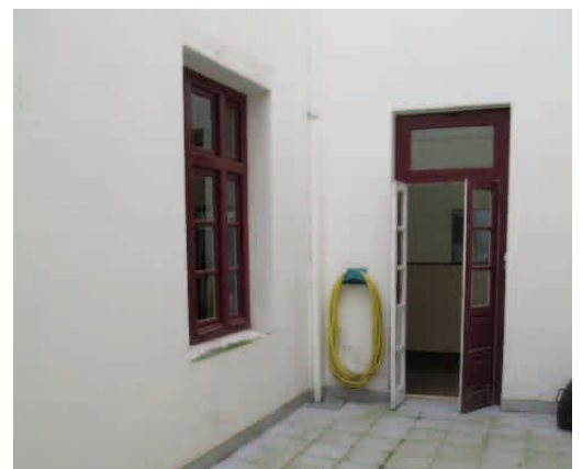
Fig. 395. Patio interior de luces, acceso en planta baja (fuente propia)
