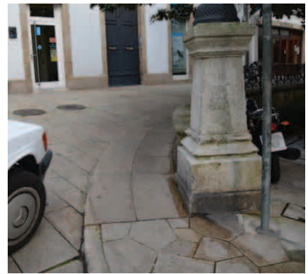
Fig. 350. Ancho libre insuficiente (fuente propia)
