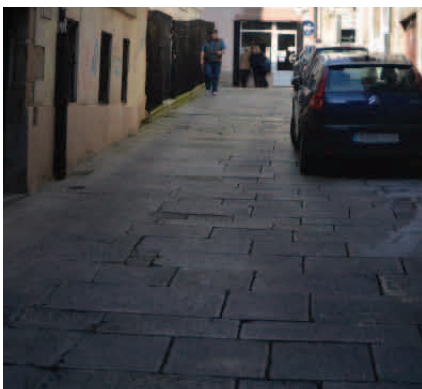
Fig. 369. Ancho libre de paso insuficiente (fuente propia)
