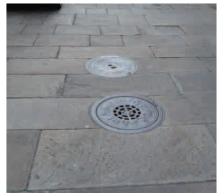
Fig. 365. Tapas de alcantarillado (fuente propia)
