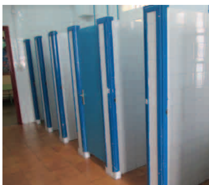
Fig. 413. Puertas de ancho libre de paso 62cm (fuente propia)
