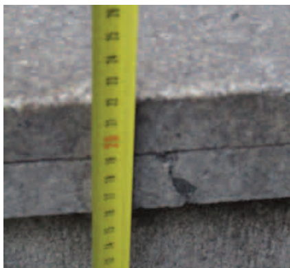
Fig. 397. Detalle de altura del peldaño (fuente propia)
