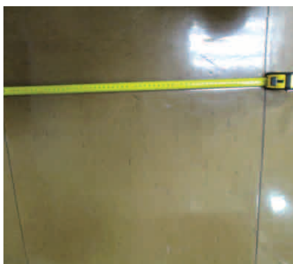
Fig. 407. Pavimento contínuo de linóleo (fuente propia)
