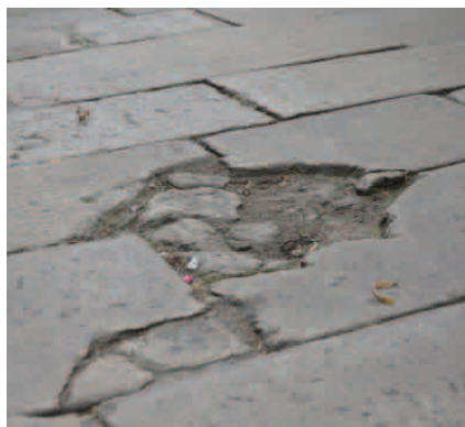
Fig. 364. Huecos, resaltes y piezas sueltas (fuente propia)
