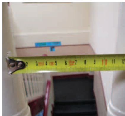
Fig. 405. Abertura libre entre barras verticales (fuente propia)
