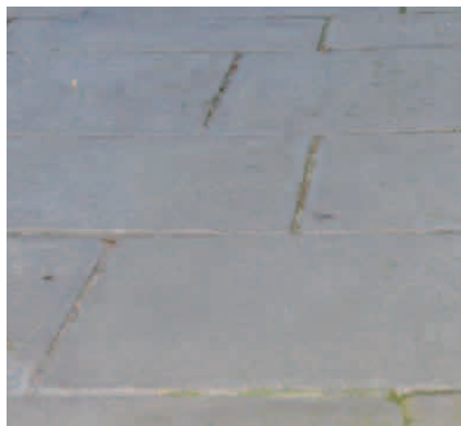
Fig. 337. Detalle del pavimento (fuente propia)
