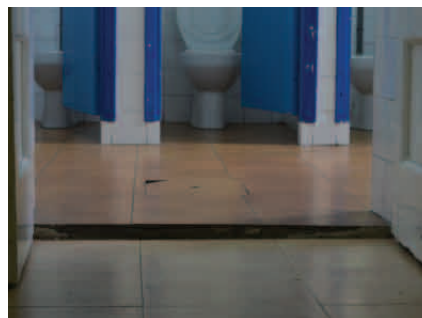
Fig. 417. Desnivel y anchura libre de paso (fuente propia)
