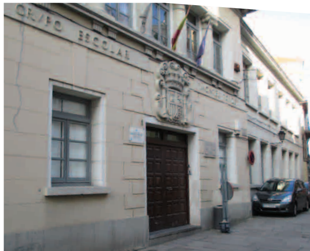
Fig. 385. Puerta de entrada del colegio (fuente propia)
