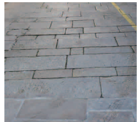
Fig. 371. Cambio de pavimento (fuente propia)
