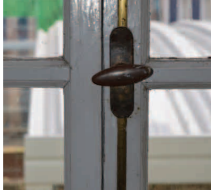
Fig. 426. Accionamiento de parte de las ventanas (fuente propia)
