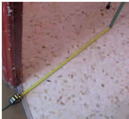
Fig. 420. Espacio de 88cm entre pupitre y puerta (fuente propia)
