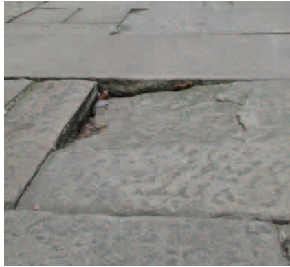
Fig. 256. Huecos y resaltes (fuente propia)
