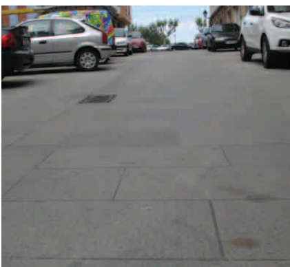
Fig. 303. ancho libre de paso y detalle de pavimento (fuente propia)
