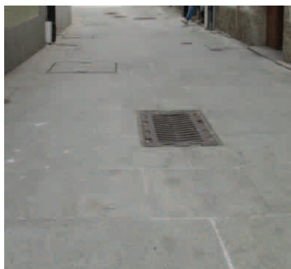
Fig. 316. Rejilla con aberturas perpediculares a la dirección de la marcha (fuente propia)
