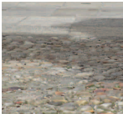
Fig. 277. Detalle de itinerario con resaltes (fuente propia)
