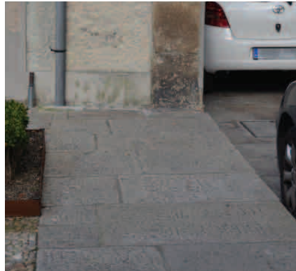
Fig. 265. Escalón (fuente propia)
