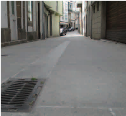
Fig. 309. Rejilla con aberturas perpediculares a la dirección de la marcha (fuente propia)
