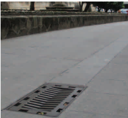
Fig. 291. Rejilla con aberturas perpediculares a la dirección de la marcha (fuente propia)
