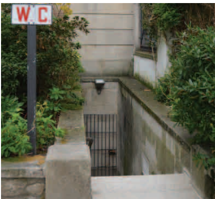
Fig. 324. Acceso a aseos mediante escalera (fuente propia)
