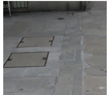
Fig. 284. Cruce con calle S. Francisco (fuente propia)
