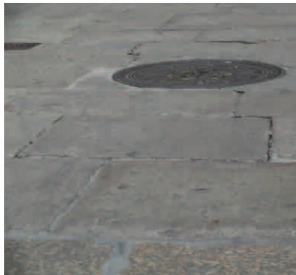
Fig. 283. Pieza suelta y pequeño resalte (fuente propia)
