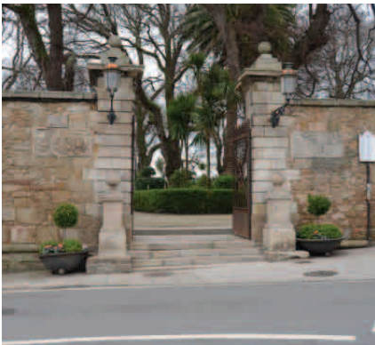
Fig. 321. Entrada principal con escalones (fuente propia)
