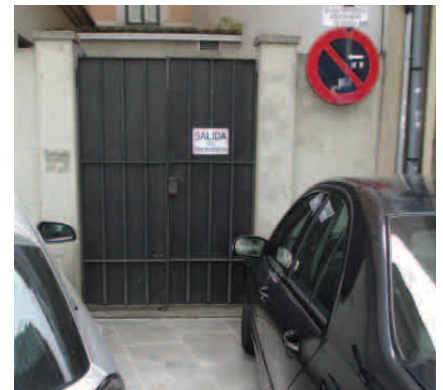
Fig. 293. Salida de emergencia del "Arquivo do Reino de Galicia" (fuente propia)
