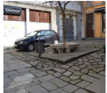
Fig. 248. Huecos y resaltes (fuente propia)
