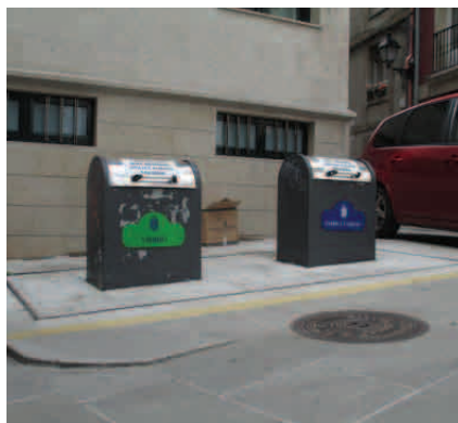
Fig. 295. Contenedores enterrados accesibles (fuente propia)
