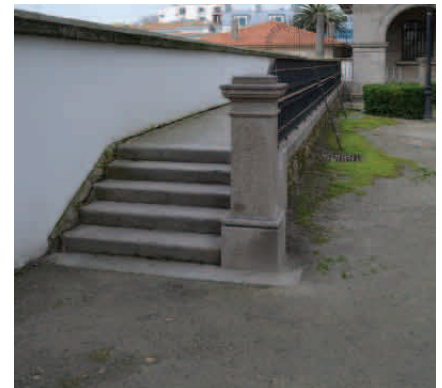
Fig. 323. Escalones para acceder a una zona (fuente propia)
