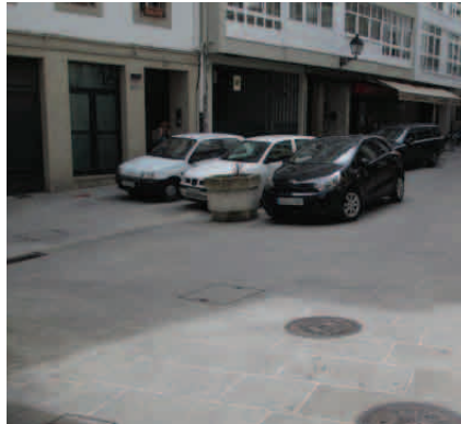
Fig. 310. Pavimento y jardinera (fuente propia)
