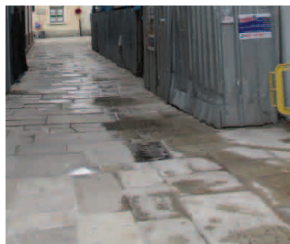
Fig. 182. Vallas de obra (fuente propia)
