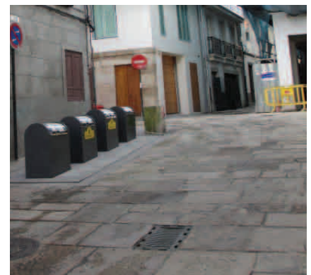
Fig. 176. Contenedores enterrados (fuente propia)
