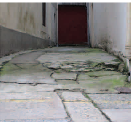
Fig. 213. Encuentro con c/Herrerías (fuente propia)
