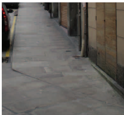
Fig. 226. Rampa con pendiente practicable (fuente propia)
