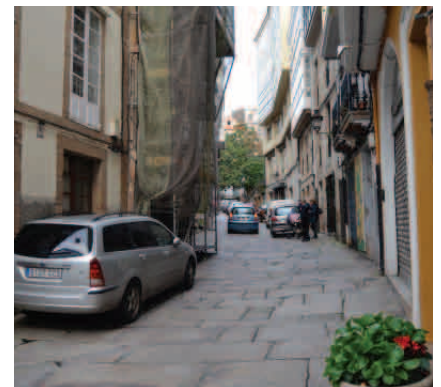
Fig. 206. Zona con obras en la vía (fuente propia)
