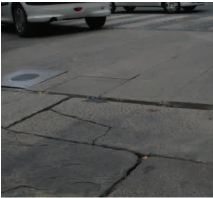
Fig. 231. Resalte y bolardo enterrado en el encuentro con c/Campo de la Estrada (fuente propia)
