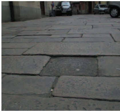
Fig. 232. Huecos y resaltes (fuente propia)
