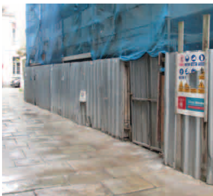
Fig. 181. Vallas de obra (fuente propia)
