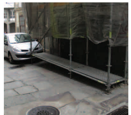
Fig. 209. Andamio en la vía (fuente propia)
