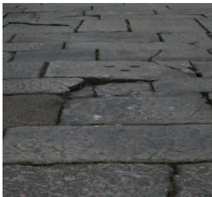
Fig. 235. Huecos y resaltes (fuente propia)
