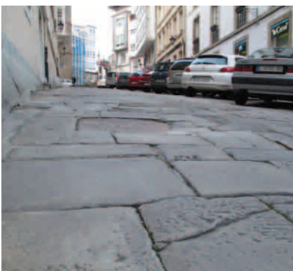
Fig. 207. Pendiente del 15%, huecos y resaltes (fuente propia)
