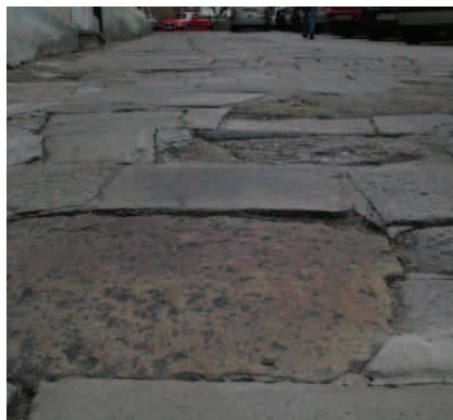
Fig. 205. Huecos y resaltes (fuente propia)
