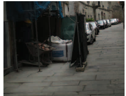
Fig. 233. Valla y puerta de obra (fuente propia)
