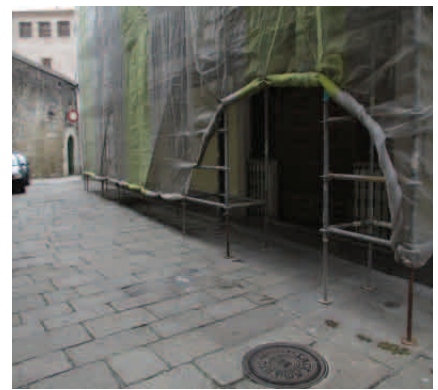
Fig. 236. Andamios en la vía (fuente propia)
