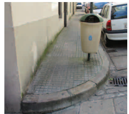
Fig. 152. Ancho acera insuficiente y desnivel (fuente propia)
