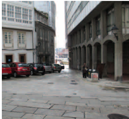
Fig. 127. Contenedores enterrados y ausencia de delimitación de zona para peatones (fuente propia)
