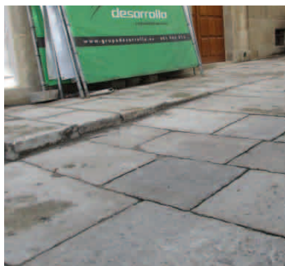
Fig. 121. Rampa (fuente propia)
