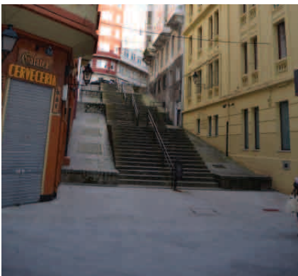
Fig. 168. Vista general de la escalera (fuente propia)
