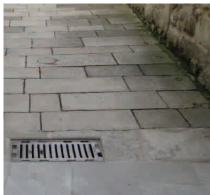
Fig. 109. Rejilla y encuentro con c/Tabernas (fuente propia)
