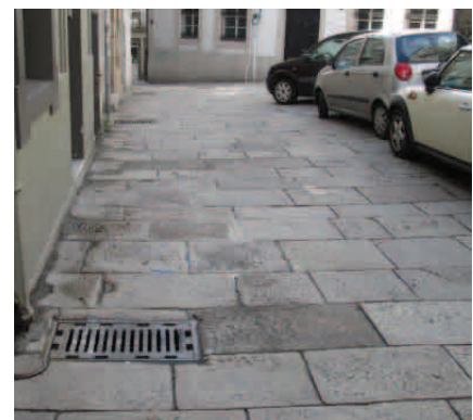
Fig. 122. Ancho libre y alcantarillado (fuente propia)
