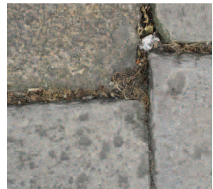
Fig. 110. Juntas entre losas (fuente propia)
