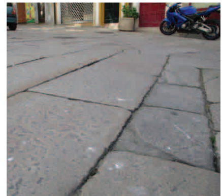
Fig. 131. Huecos y resaltes (fuente propia)
