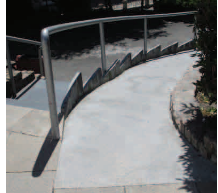
Fig. 143. Rampa con 16% de pendiente (fuente propia)
