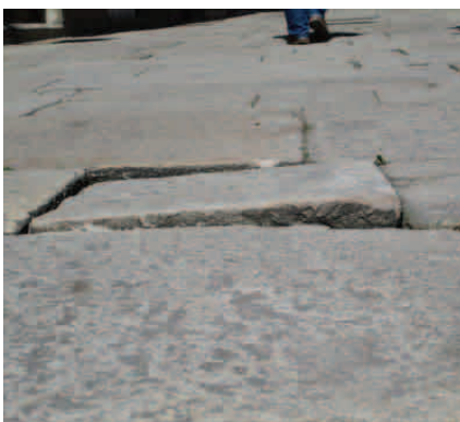
Fig. 120. Pieza suelta, hueco y resalte (fuente propia)
