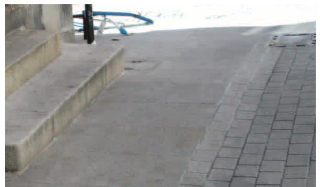
Fig. 66. Adoquinado de granito gris en la canalización de la calle Alfonso IX (fuente propia)
