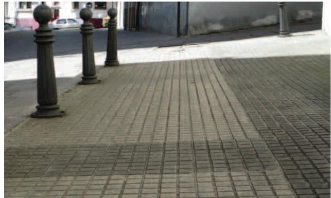
Fig. 68. Embaldosado con baldosa hidráulica (fuente propia, c/Alfonso IX)
