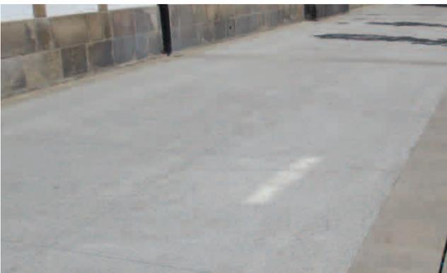
Fig. 73. Pavimento de hormigón (fuente propia, c/General Alesón)
