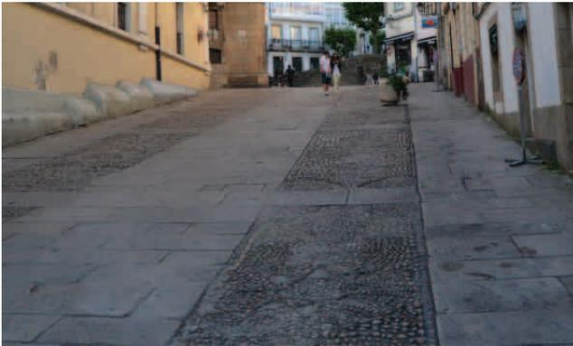
Fig. 62. Empedrado tradicional de cantos rodados combinado con enlosado tradicional de granito pardo (fuente: propia, c/Damas)
