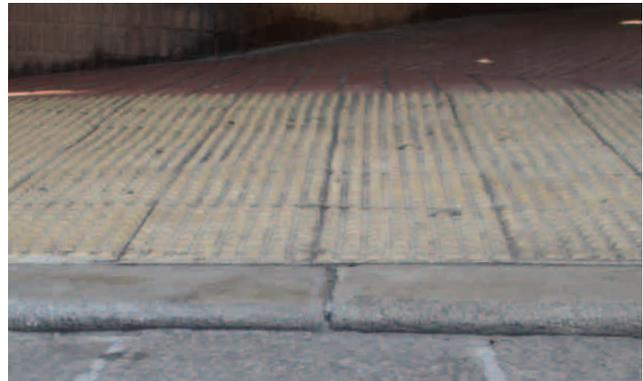
Fig. 69. Embaldosado con baldosa hidráulica (fuente propia, c/Alfonso IX)
