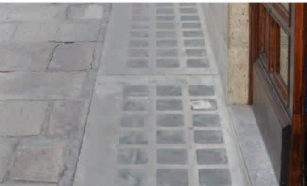
Fig. 74. Hormigón con piezas de vidrio moldeado (fuente propia, c/Santiago)
