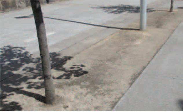
Fig. 71. Tierra compactada en un alcorque (fuente propia, c/General Alesón)
