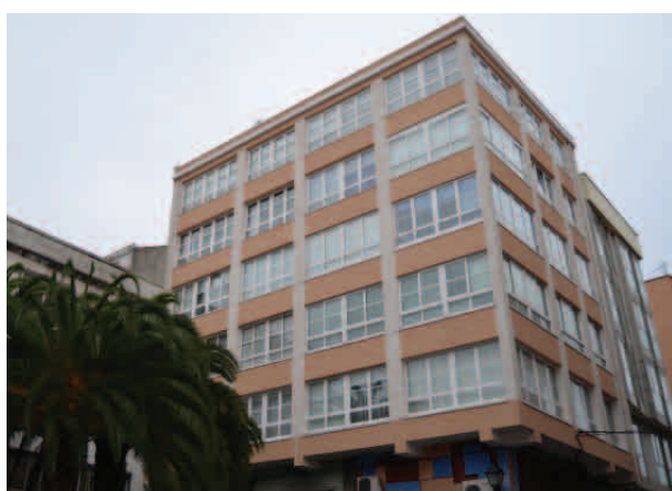
Fig. 13. Edificio de cinco alturas (fuente propia, c/Isabel López Gandalla, junto a la plaza de Santo Domingo)
