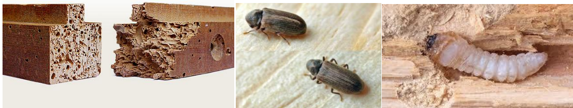
Figura 60: Madera afectada por la carcoma.
