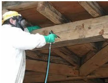
Figura 77: Aplicación del tratamiento protector con pistola pulverizadora.
