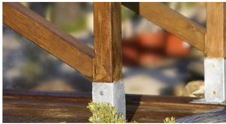
Figura 85: Arranque metálico del pilar para protegerlo de la humedad del terreno.
