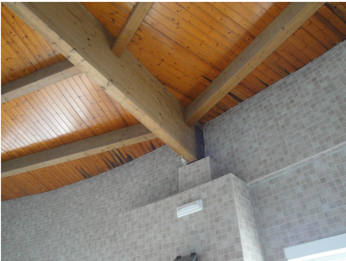
Figuras 213 y 214: Unión de la viga principal al muro perimetral, que se apoya a la pilastra.
