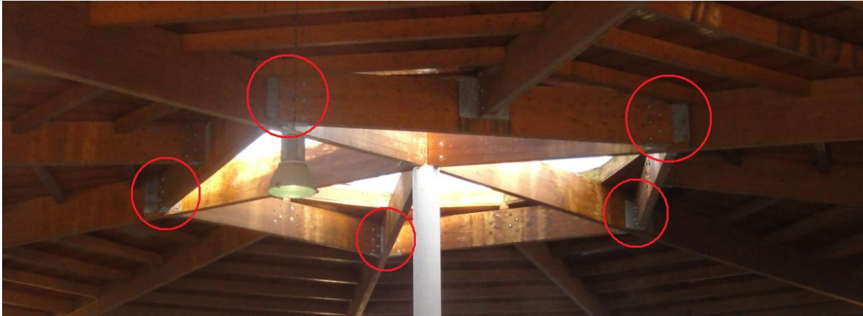
Figura 198: Situación de las uniones metálicas de la viga transversal a la viga principal.
