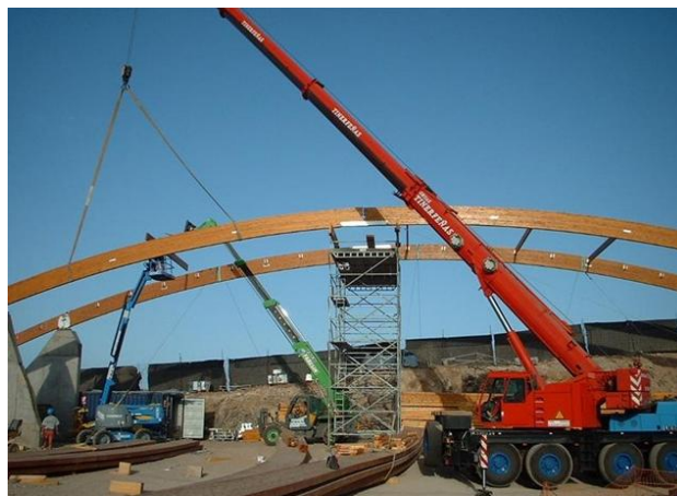
Figura 118: Colocación en obra de las vigas mediante abrazaderas con ayuda de una grúa.
