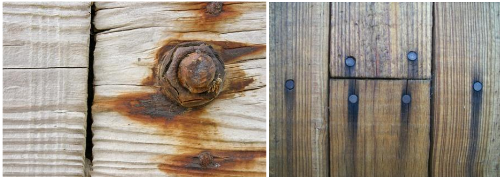
Figura 63: Producción de manchas en la madera de color rojo parduzco debido al óxido de hierro. Fuente: caborian.com
