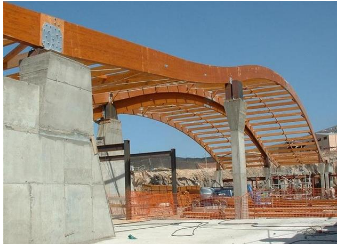
Figura 117: Separación en obra de la zona donde se sitúan los útiles de montaje de la estructura.
