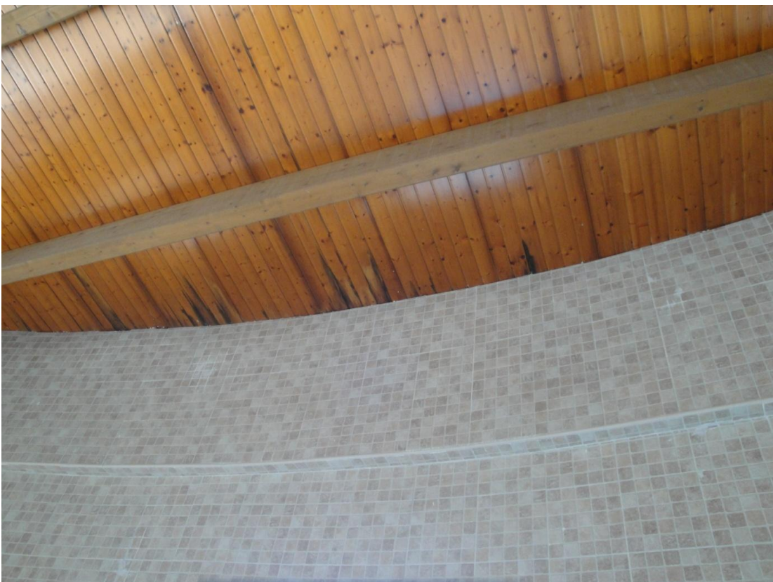
Figuras 211 y 212: Vista de las correas y del material de cubrición con los paneles tipo “thermochip”.
