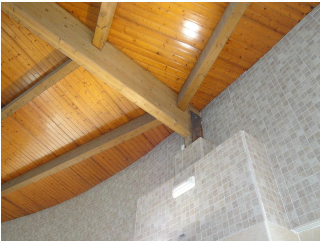
Figuras 215 y 216: Unión de la viga secundaria al muro perimetral, que se apoya a la pilastra.
