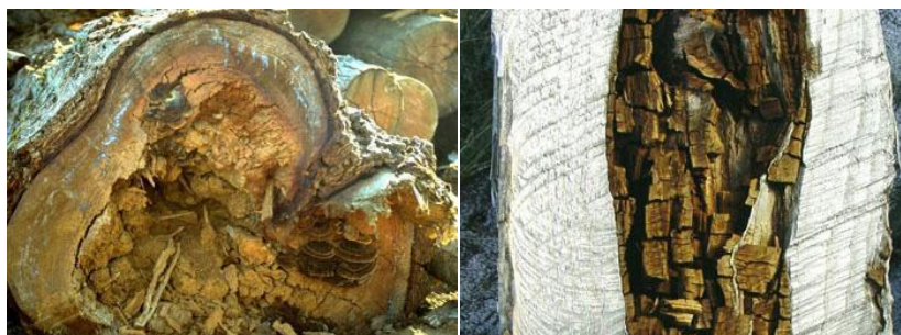
Figura 58: Madera afectada por hongos de pudrición.
