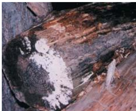
Figura 56: Madera afectada por el moho.
