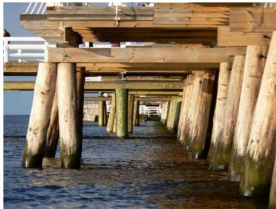
Figura 15: Muelle de madera sometido a salpicaduras y variación de humedad.
