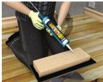
Figura 127: Aplicación de adhesivo de poliuretano con pistola manual.
