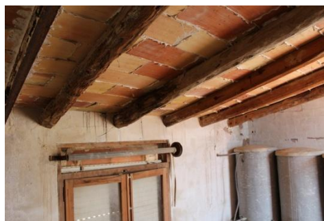
Figura 84: Viguetas de madera en mal estado debido a filtraciones de la planta superior.
