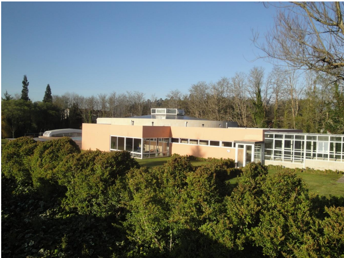
Figura 202: Vista exterior del balneario. Fotografía sacada desde el aparcamiento.
