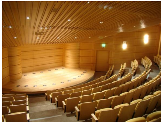
Figura 17: Auditorio revestido de madera para mejorar las condiciones acústicas del local.
