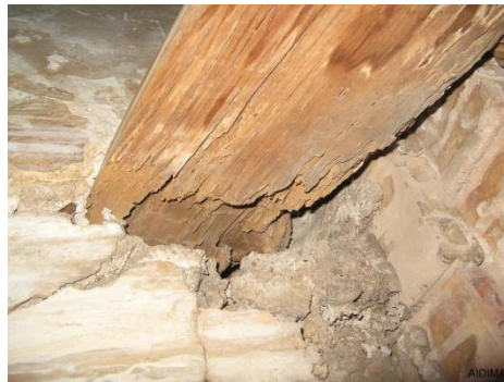
Figura 83: Viga de madera deteriorada por la humedad en el muro.
