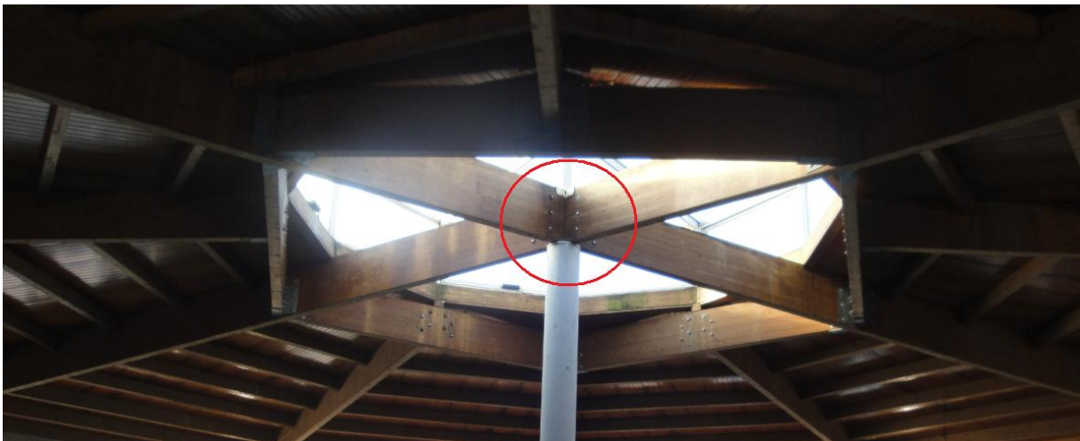
Figura 197: Situación de la unión metálica de las vigas al pilar central.
