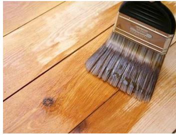
Figura 76: Aplicación del tratamiento protector mediante brocha.
