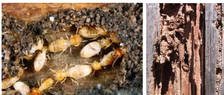
Figura 59: Madera afectada por termitas.
