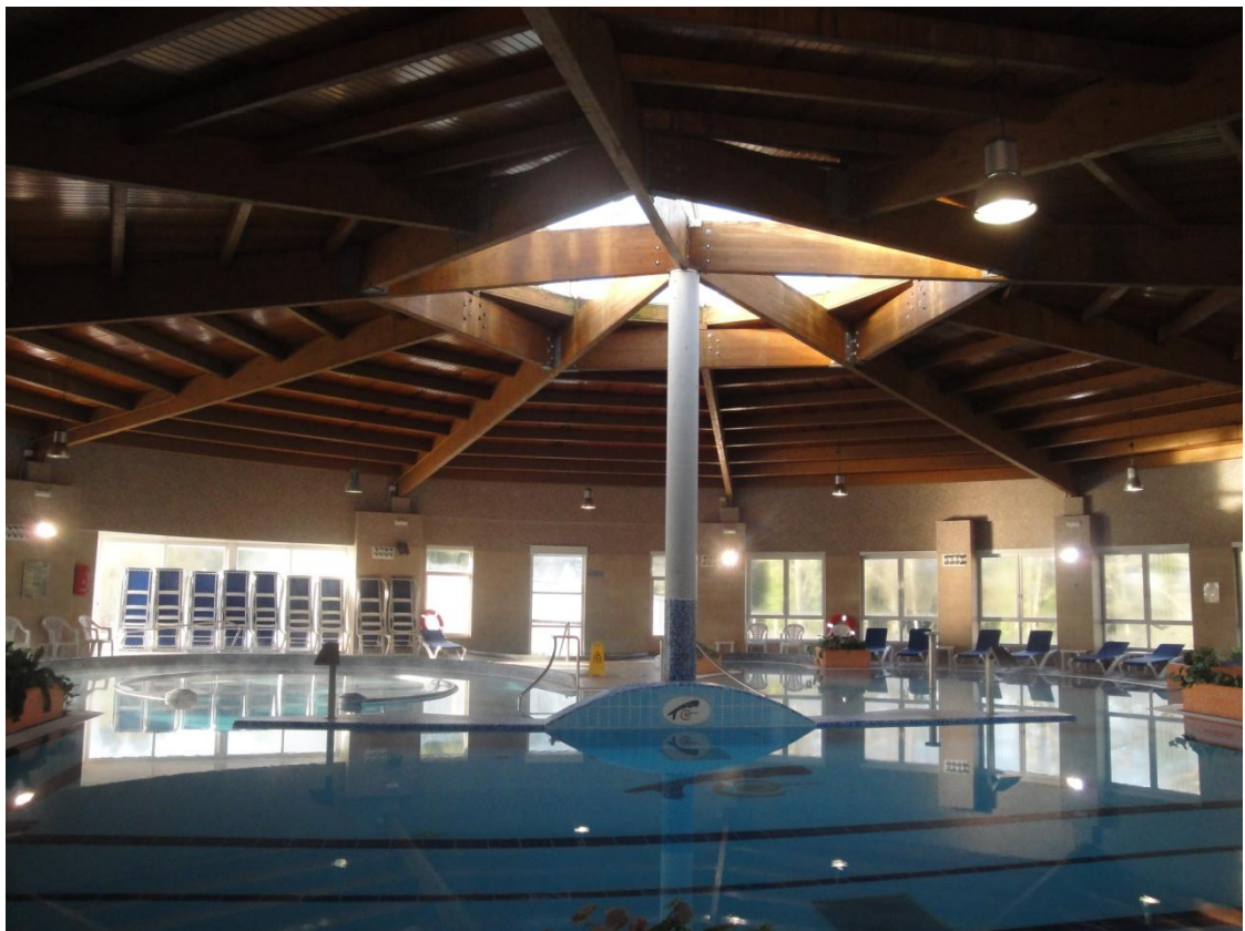
Figuras 205 y 206: Vista general del interior del Acuaform.
