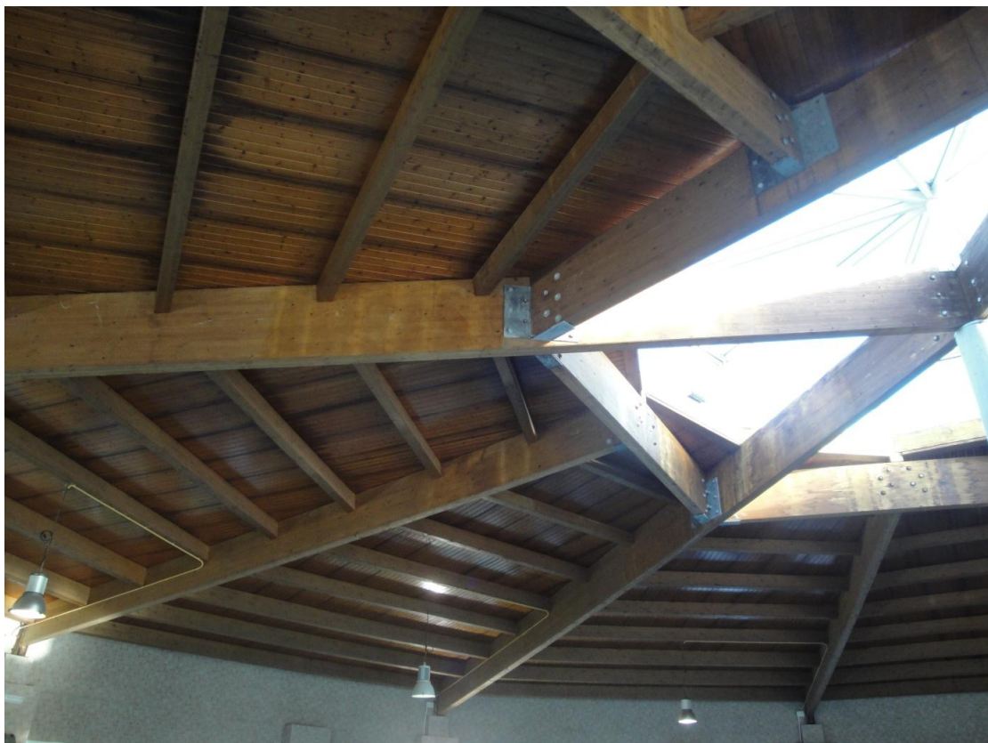
Figuras 209 y 210: Vistas de la estructura de MLE y de las uniones metálicas.
