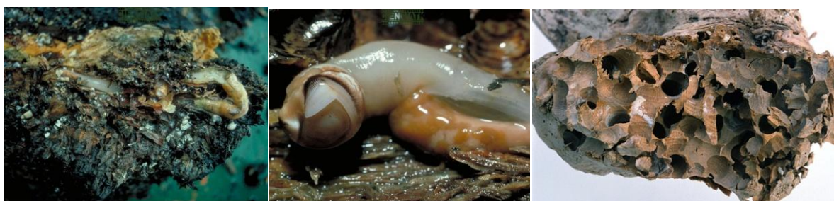
Figura 61: Madera afectada por el teredo.
