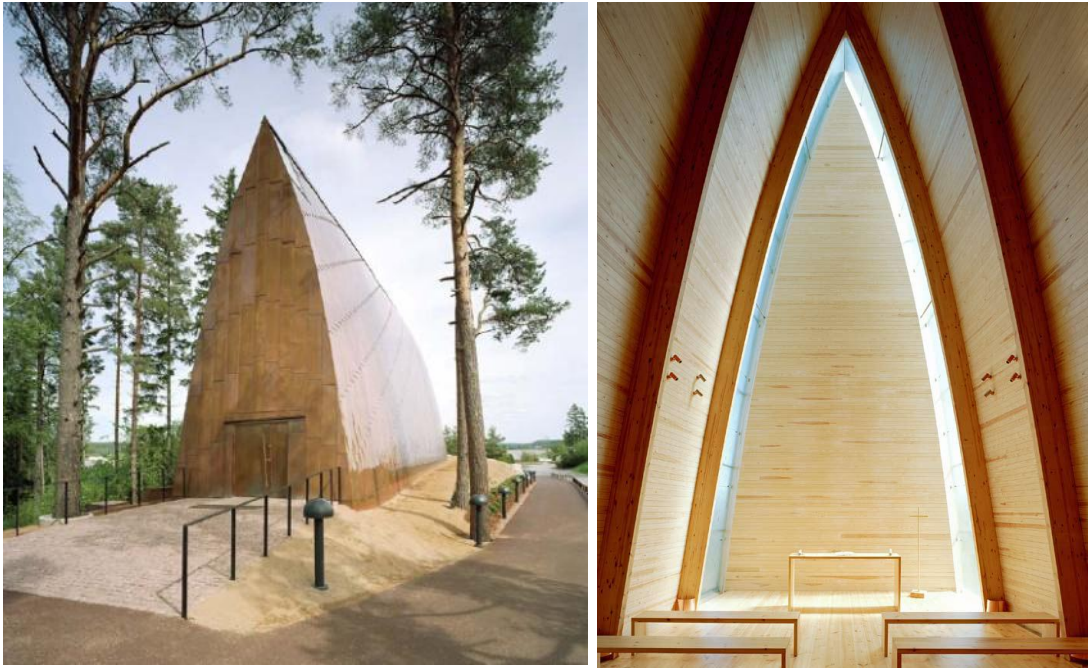
Figura 93: Capilla ecuménica en Turku (Finlandia). Arquitecto: Matti Sanaksenaho. Fuente: arqred.com
